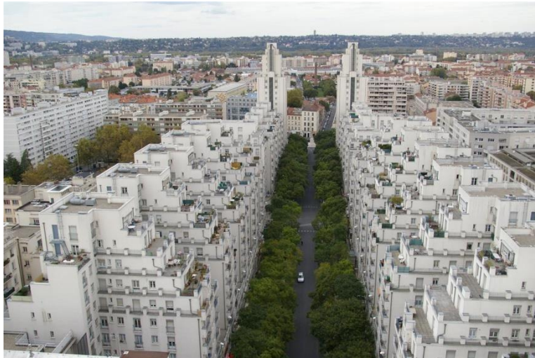
Figure 2.6 : les grattes ciel (Villeurbanne) - Maurice Leroux - 1934, source: www.leprogres.fr
