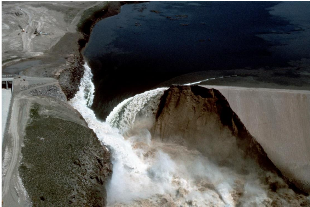
Figure 25 : barrage de Teton en 1976 (www.structurae.net)
