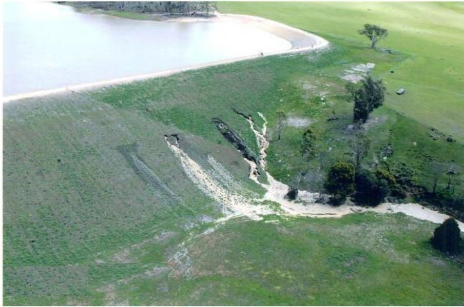
Figure 15 : Rupture par Erosion interne de la digue de Tunbridge, Tasmania
