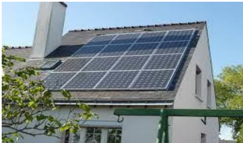
Figure.I.5. Exemple d'ombrage partiel.
