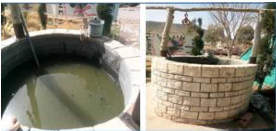
Figure11 : un puits artificiel dans pépinière de hammamet (photo personnel)
