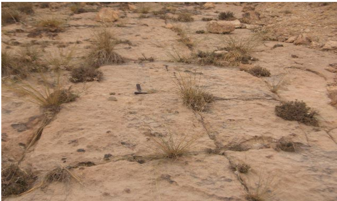
Figure.IV.2. Réseau de diaclases sur les dalles de calcaires Yprésien-Lutitien du gradin de Kef Es Sennoun.
