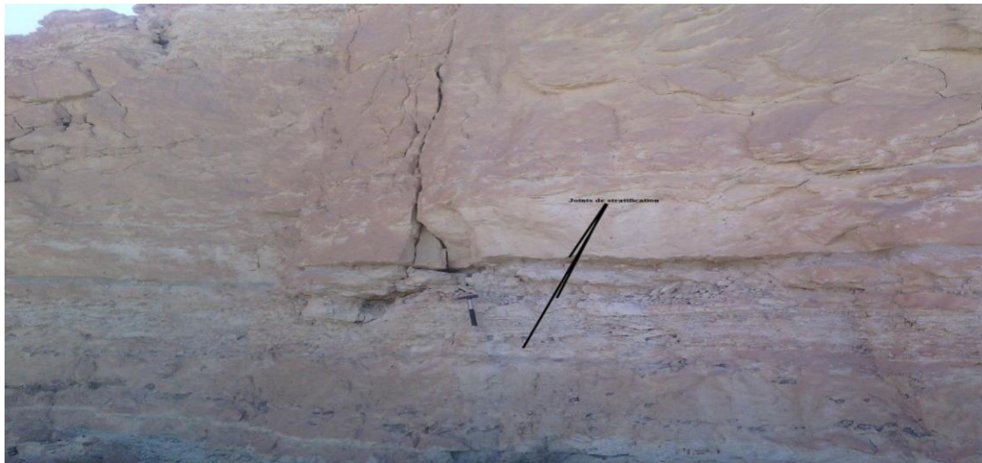
Figure.IV.1. joint de stratification (photo prise d'un gradin de Kef Es Sennoun).
