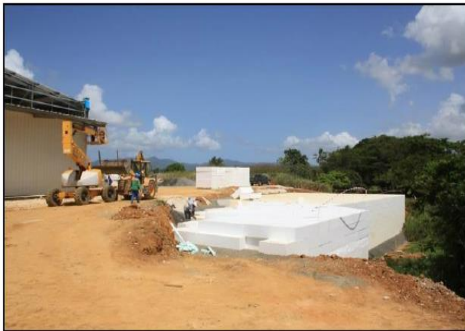
Figure II.15. Remblai allégé.
