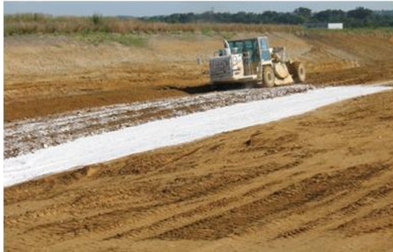
Figure II.8. Traitement à la chaux [5].
