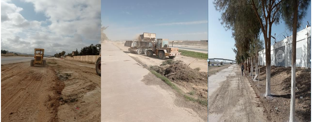
Figure 51: Opérations de nettoyage
