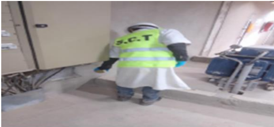
Figure 40: Vérification et recharge des extincteurs
