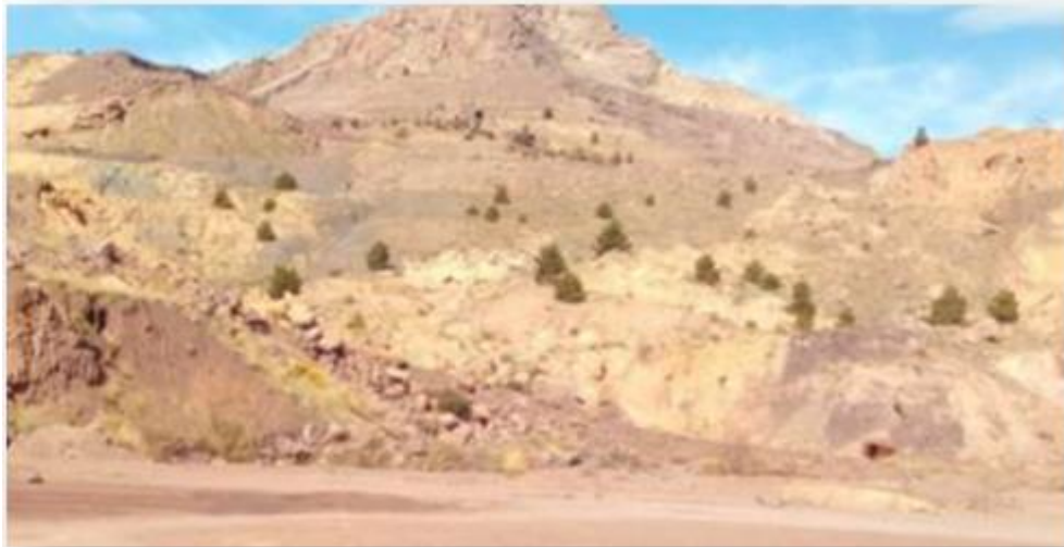
Photo I.9: Glissement de Quartier El ZARGA (la mine de fer d'Ouenza).
