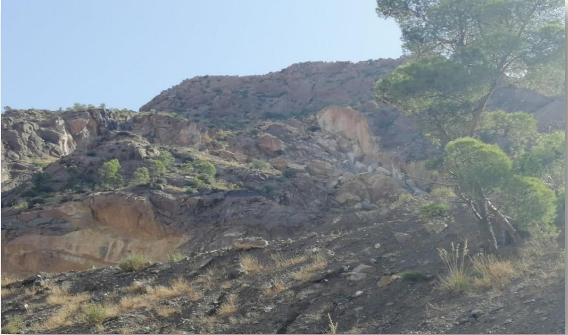
Photo II.1 : Un effondrement dans le niveau 1285. [34]
