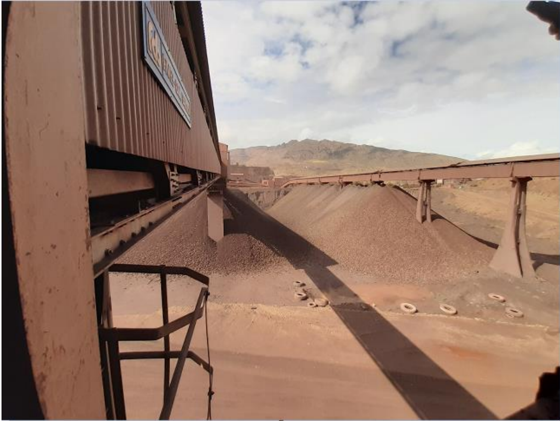
Figure IV.10 : stock concassée destinée pour le client de l'usine sidérurgique el hadjar
