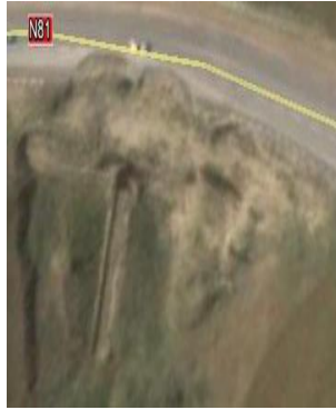
a- Hammam Tassa PK 114
