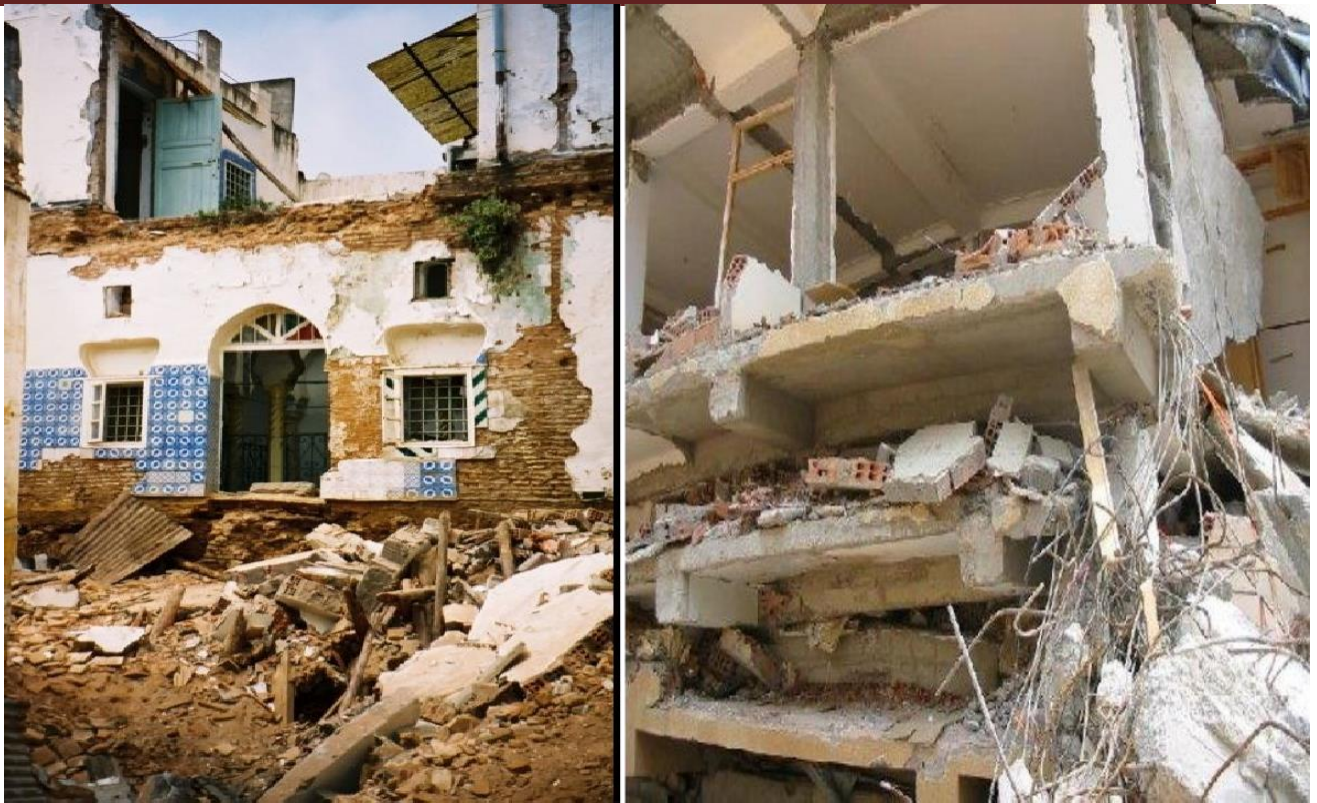
Figure .I.3. séisme de 21 mai 2003 à Boumerdès. [1]
