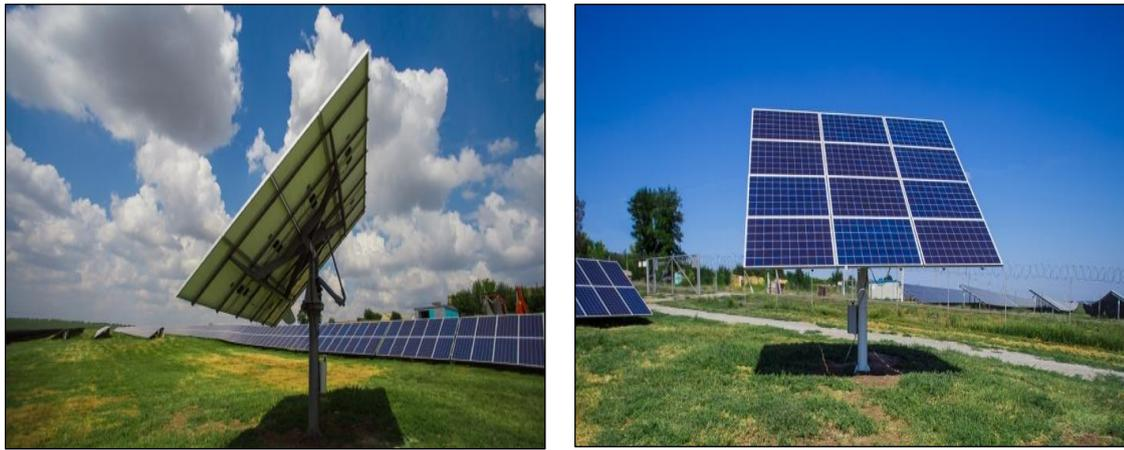
**Figure II.3 :** Suiveur solaire automatique [36].
