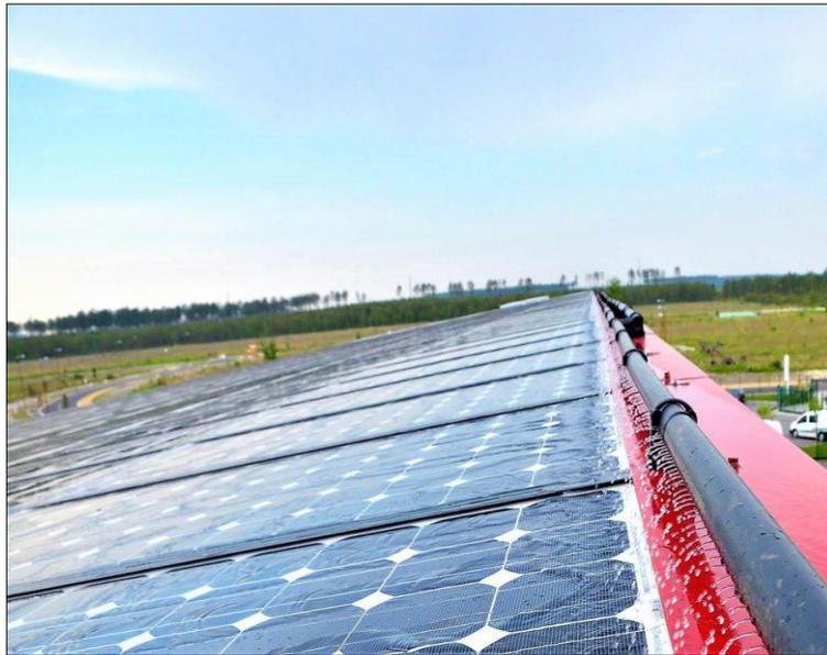
Figure II.10 : Panneau solaire refroidie [43].
