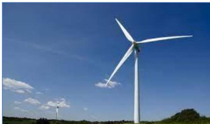
Figure III.33 : éoliennes à axe horizontal.
