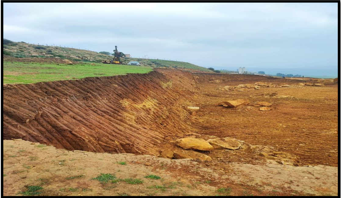
Figure II.29 : État des terrains après terrassements
