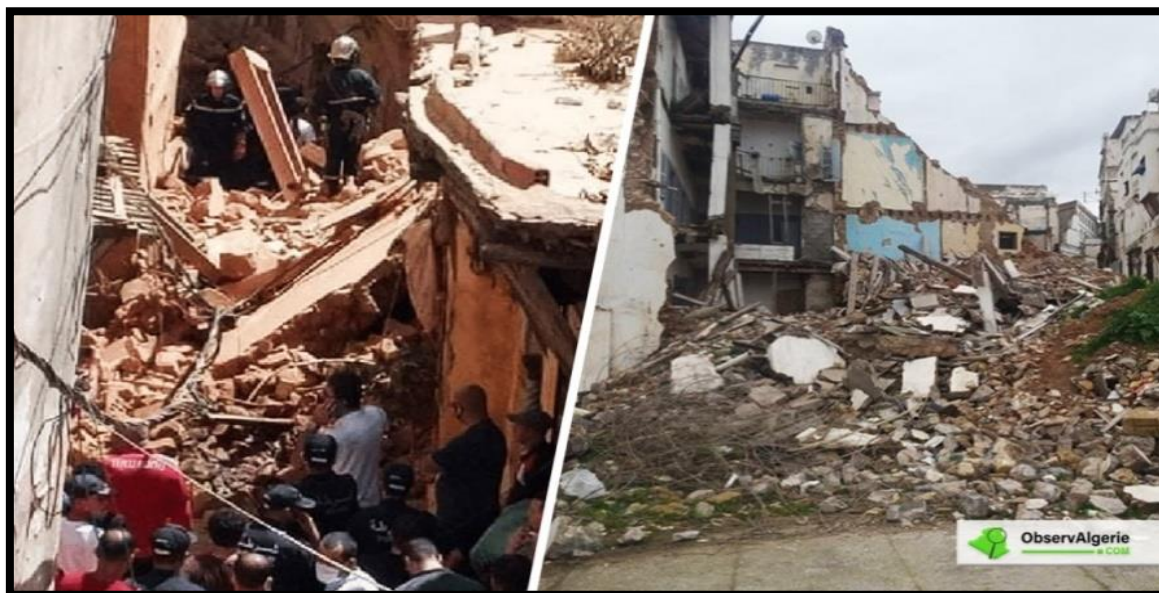
Figure I.26 : Effondrement de Casbah (5juin 2020). [14]
