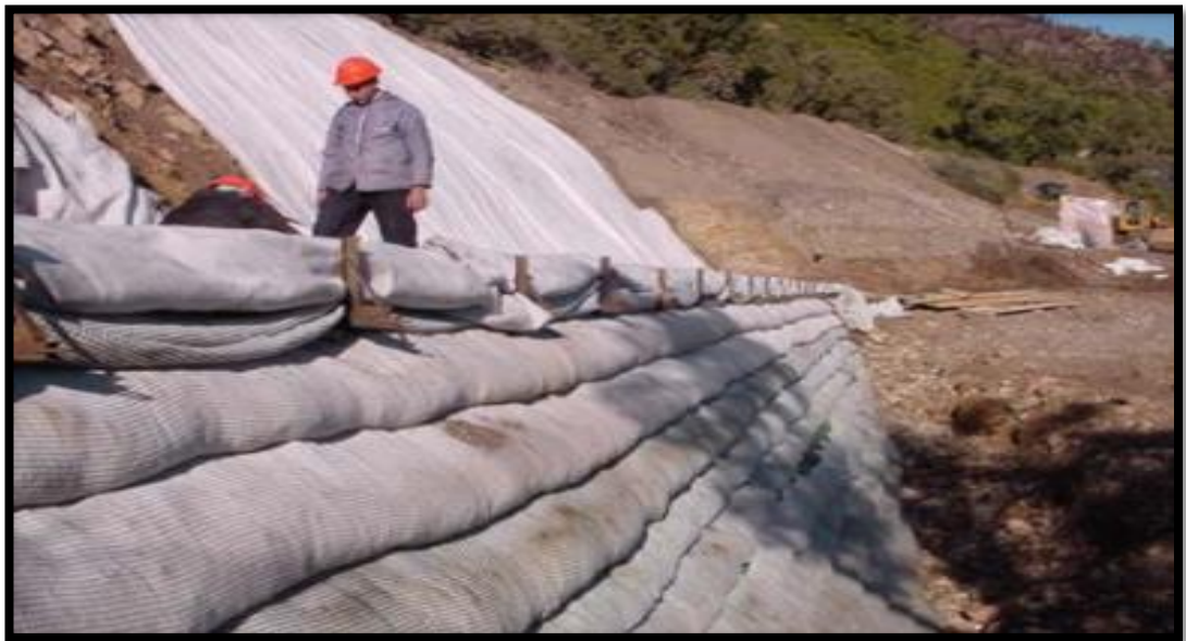
Figure I.23 : Construction de l'ouvrage par couches [13].
