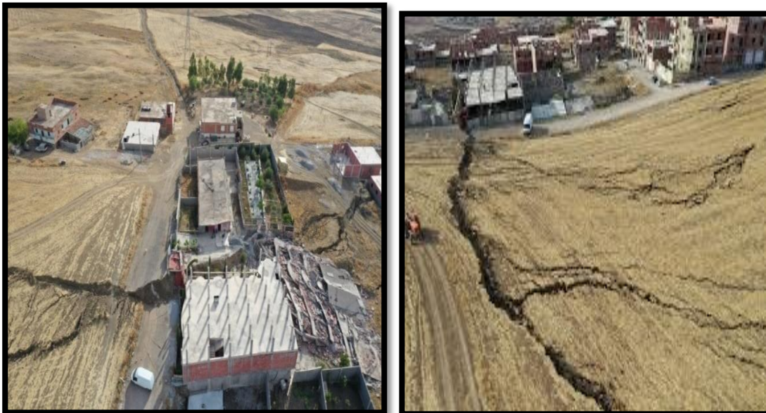
Figure I.25 : Glissement de Mila (7 Août 2020). [14]
