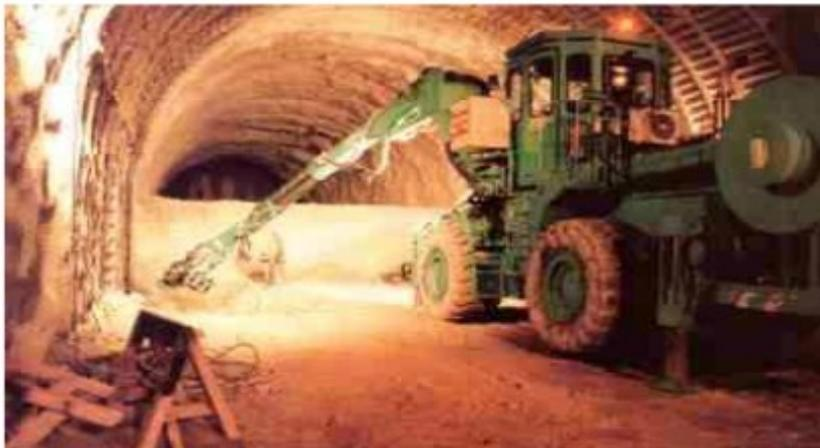
**Figure I.18** : Creusement en demi-section. [6]
