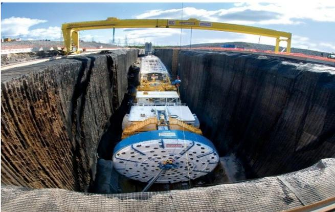
**Figure I.21** : tunnelier à bouclier simple.
