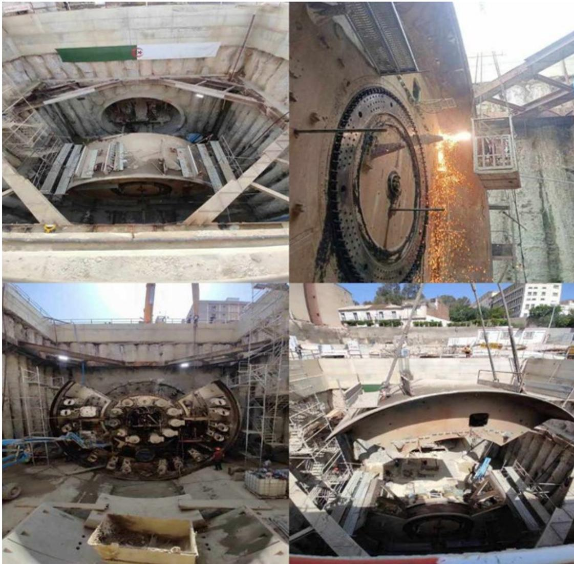
**Photo II.6** : Sortie et désassemblage de tunnelier (Métro d'Alger extension LOT1)
