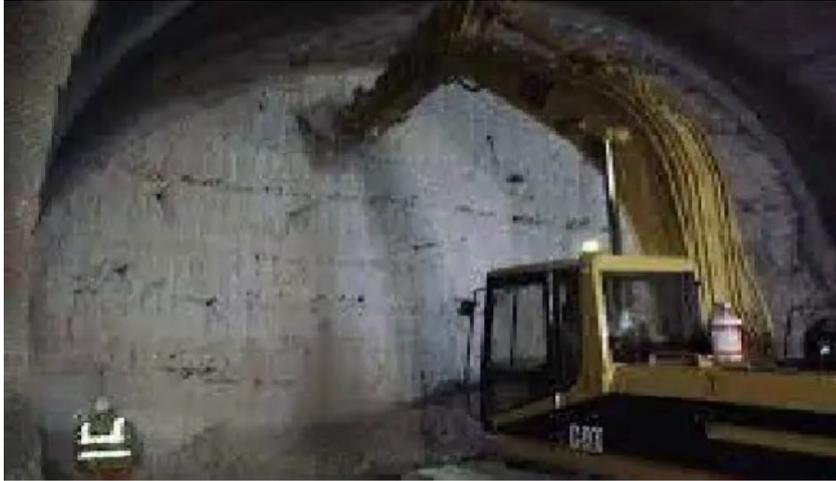
**Figure I.20** : le prédécoupage mécanique
