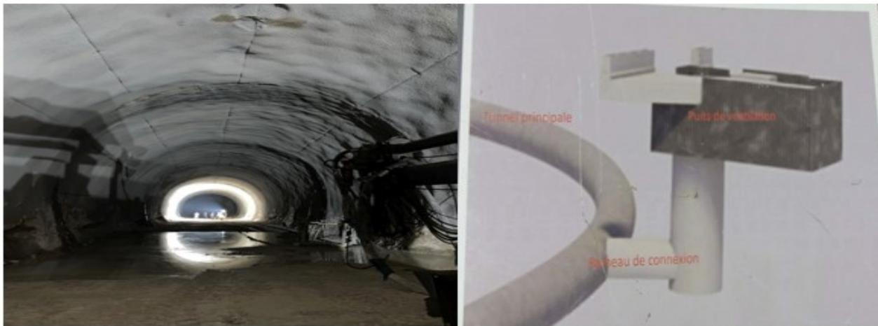
B. Le rameau de connexion (pour relie le tunnel avec le puits de ventilation).
