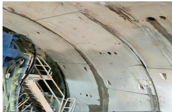
**Photo II.5** : Problème des infiltrations qui nécessite l'injection de coulis
