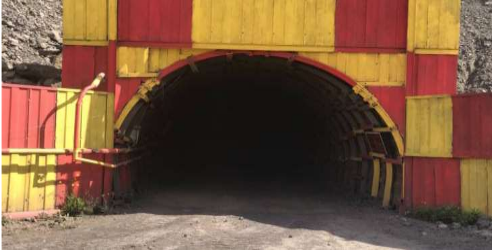
Figure II.8: galerie de niveau 1105 axe principale, les mines de fer de l'Est, BOUKHADRA
