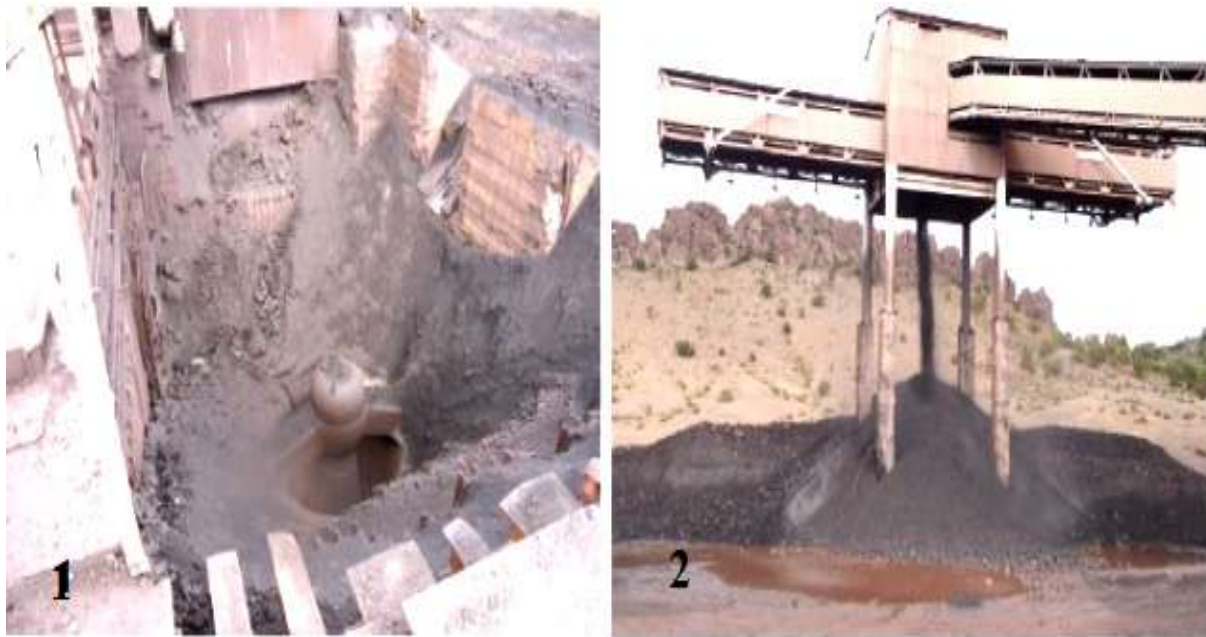
Figure. IV.4: concasseur giratoire et Exemple sur le phénomène de lessivage du minerai de fer de Boukhadra à la sortie concasseur.
