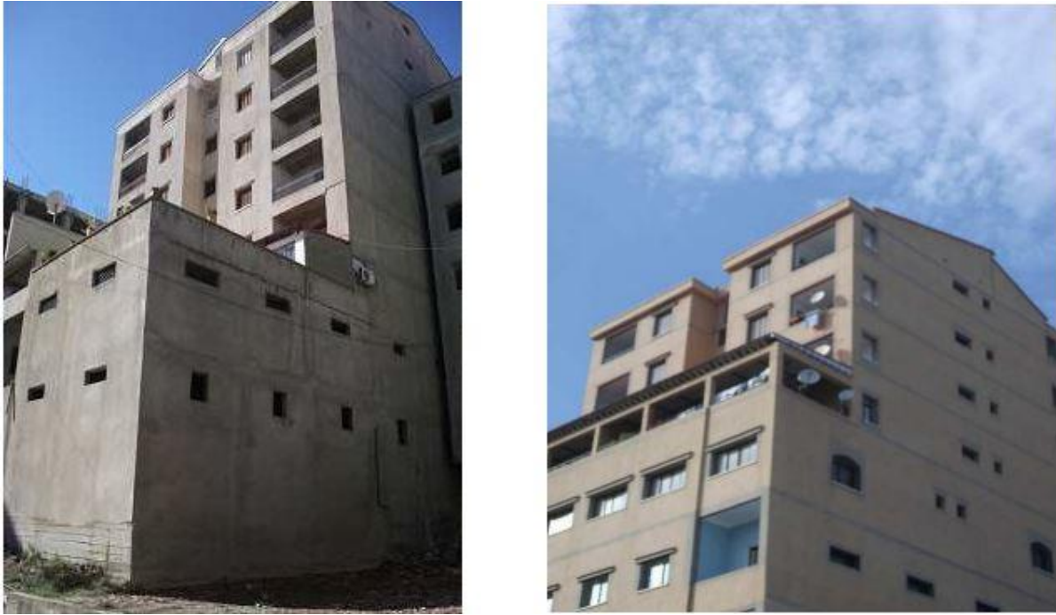
Figure IV-3 : Photos de bâtiments irréguliers en élévation.
