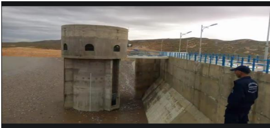
Figure 2.7 Vue latérale de la structure du barrage
