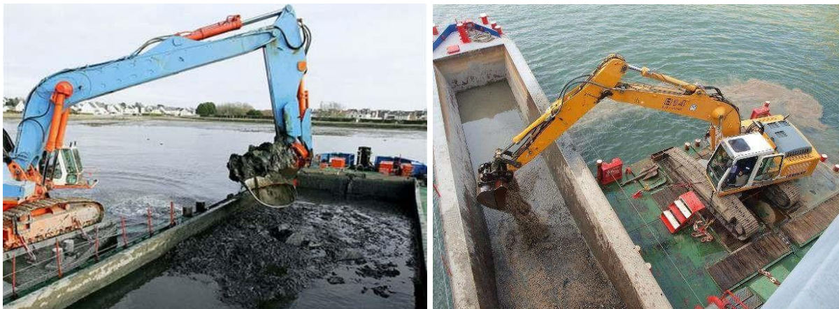
Figure 1.14 Dragage mécanique
