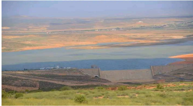
Figure 2.3 le barrage de Safsaf el Ouesra (wilaya de Tebessa)
