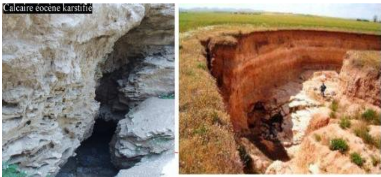
Fig 53. effondrement et karstification des calcaires Éocène « Douamis »
