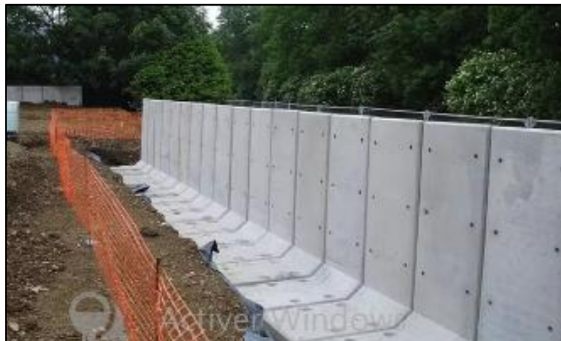
Figure I.5. Mur de soutènement en béton armé auto-stable
