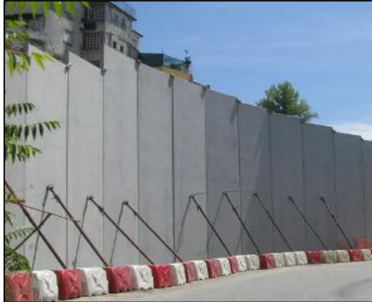
Figure I.6. Murs en béton armé ou mur cantilever
