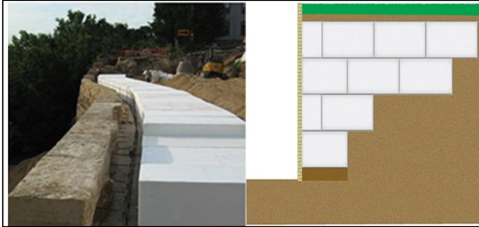
Figure I.24. Amélioration de soutènement avec la géofoam
