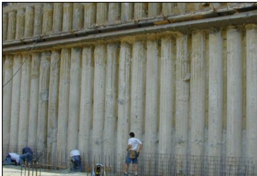
Figure I.9. Les parois constituées de pieux
