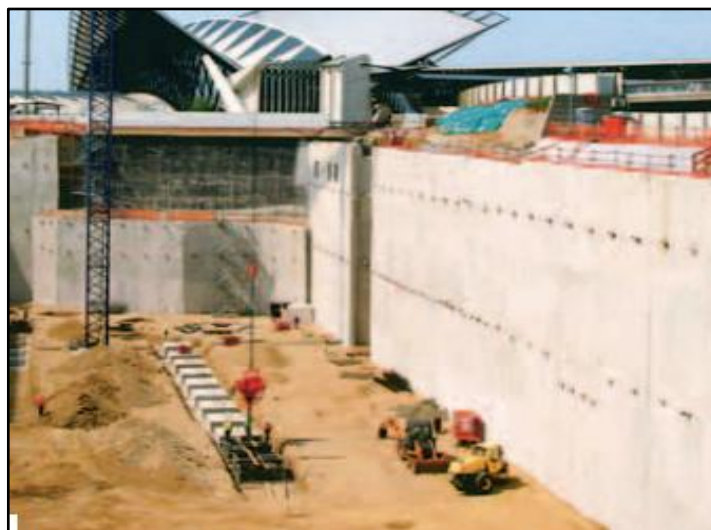
Figure I.7. Les parois moulées
