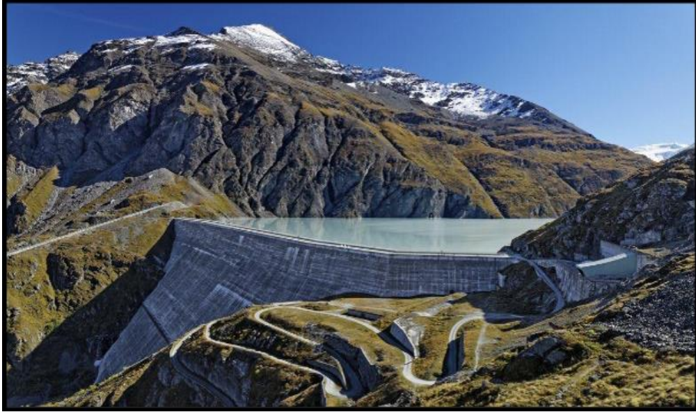
Photo N° 02 : barrage poids grande-Dixence en suisse le plus haut au monde 284m (Martinez Bres)
