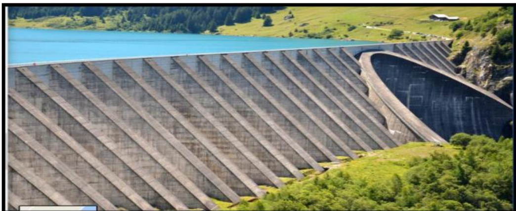
Photo N° 04 : vue générale du barrage Roselend France (geosoc.fr)
