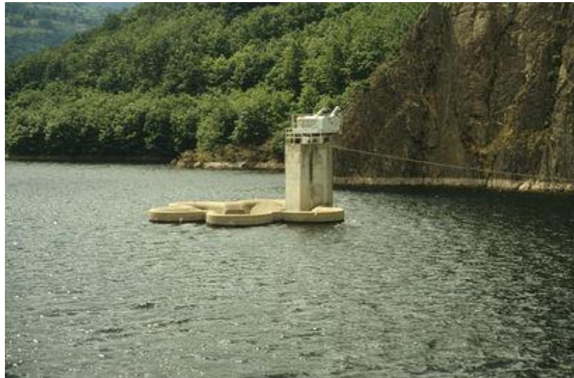
Photo N° 12 : Evacuateur de crue en tulipe du barrage de Rouchain (Loire) INRAE – G2DR)
