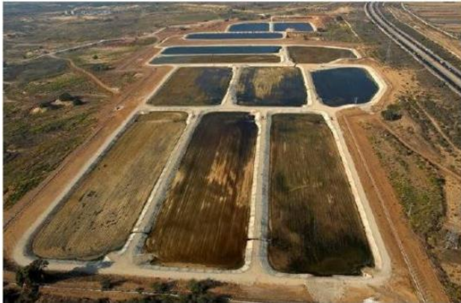
Photo N° 25 : Recharge par Bassins à sable (ABAIDIA, S. 2008)
