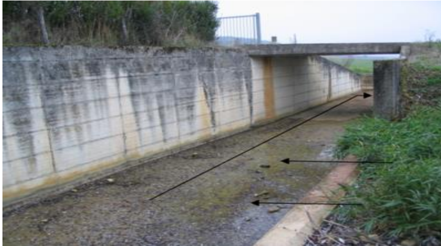
Photo N° 9 : Evacuateur à entonnement latéral – Les flèches indiquent le sens du flux (Photo C. Curt - INRAE - G2DR).
