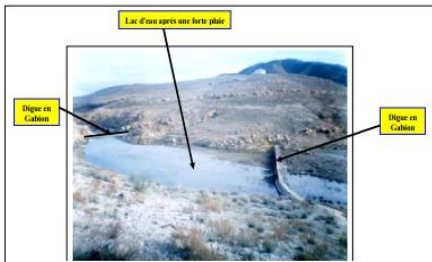
Figure N° 34 : Lac d'eau formé en amont d'oued Bouakous après une Forte pluie dans la région de Hammamet. (In thesis K.SGHIR, 2008)
