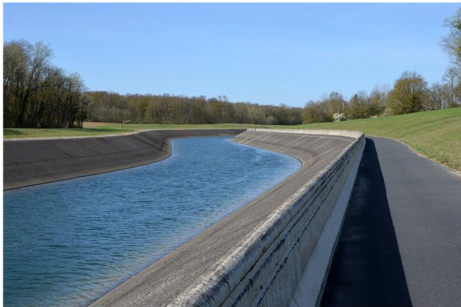
Photo N° 14 : Canal d'amenée du lac de Der, Haute-Marne, Champagne, France
