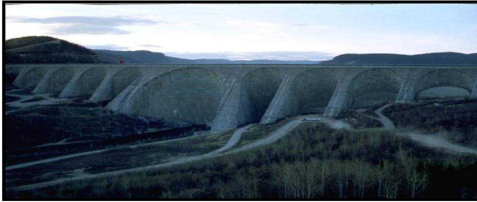
Photo N° 05 : barrage Daniel Johnson 214m, Quebec (JM Chouinard)
