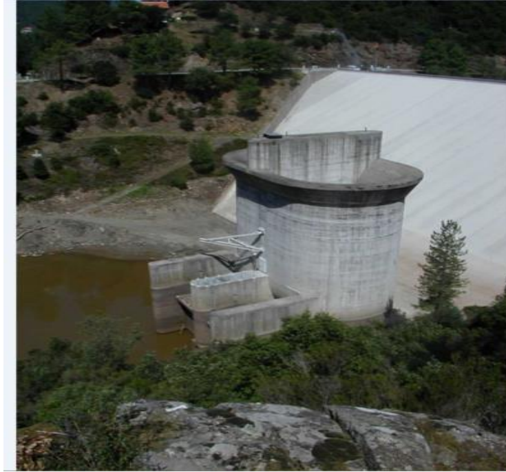
Photo N°10 : Exemple d'évacuateur de fond. (Photo INRAE - G2DR).
