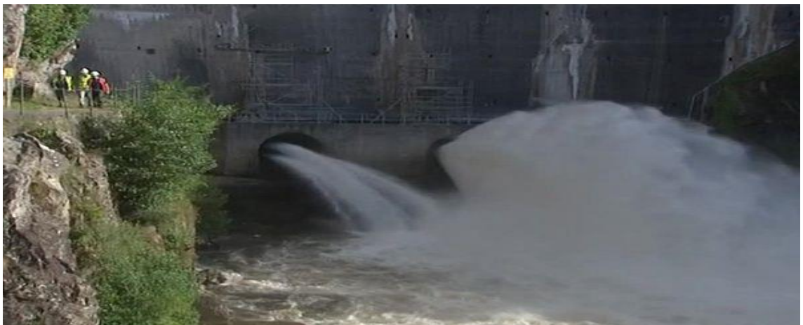
Photo N° 20 : La vidange du barrage de mériges à débité (France)
