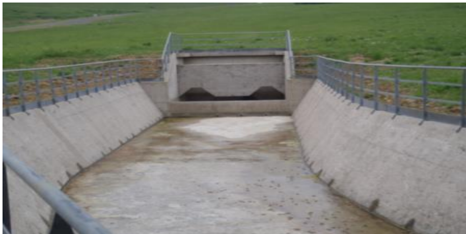
Photo N° 18 : Bassin de dissipation. (Photo INRAE - G2DR)
