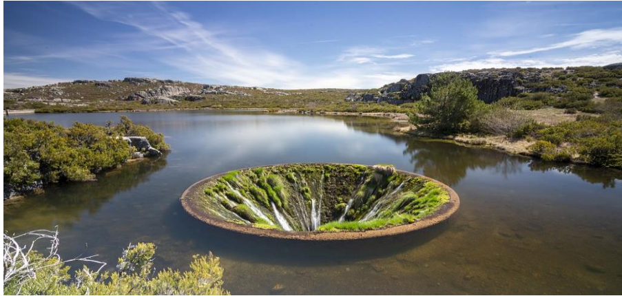
Photo N° 16 : Le déversoir du lac artificiel dans la Serra da Estrela au Portugal. Mai 2022
