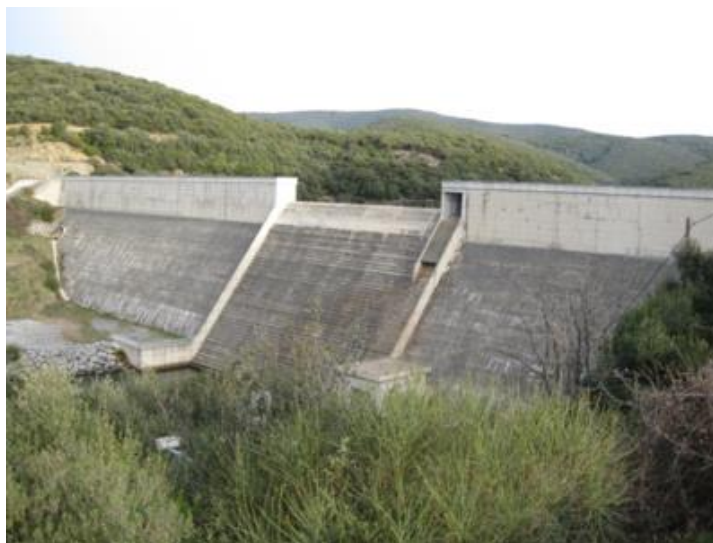
Photo N° 08 : Evacuateur à entonnement frontal. (Photo C. Curt - INRAE - G2DR).
