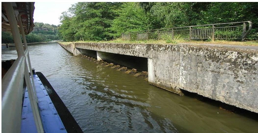
Photo N° 17 : Déversoir sur canal de la Marne au Rhin.
