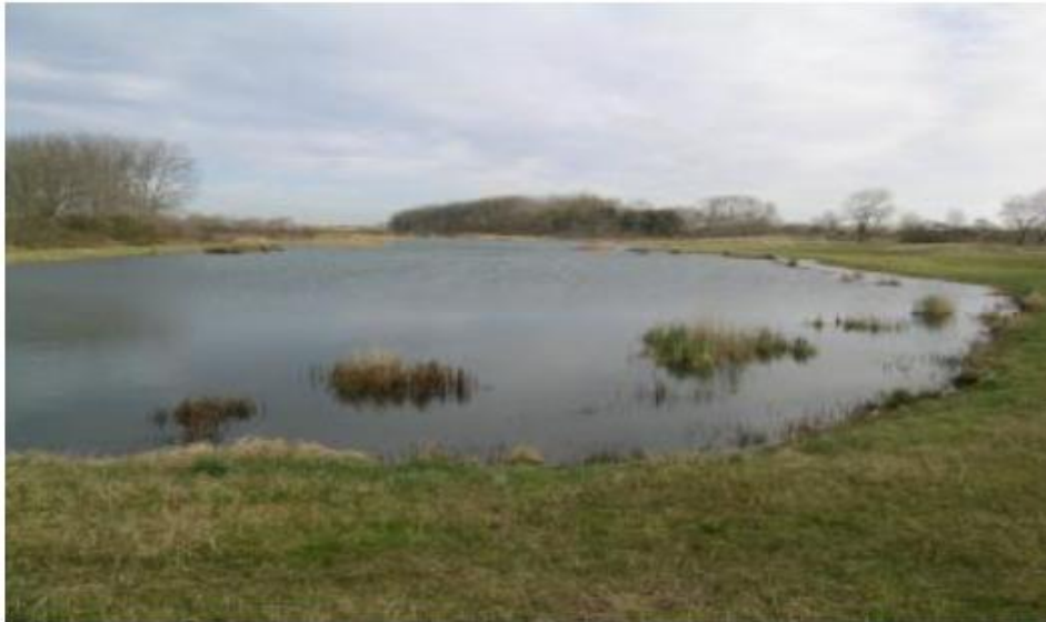
Photo N° 24 : Recharge artificielle par Bassins à végétations (ABAIDIA, S. 2008)
