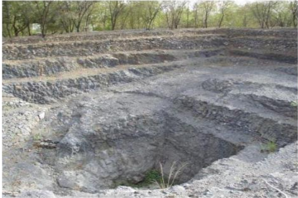
Photos N° 30 : Photos d'un Fosses de filtration (ABAIDIA, S. 2008)
