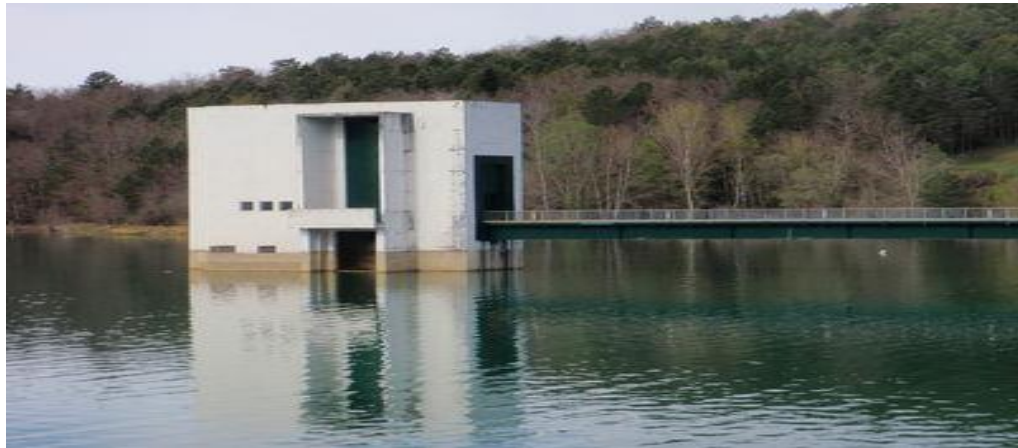
Photo N° 21 : Tour de prise Barrage de Montbel (Ariège) INRAE – G2DR
