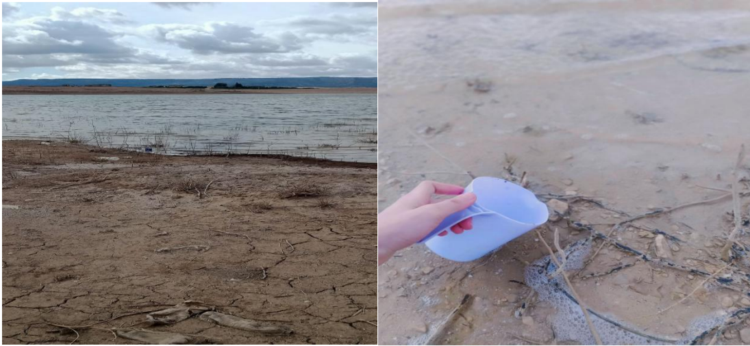
Figure 07 : le barrage de Ain Zarga (Photo originale, 2024)
