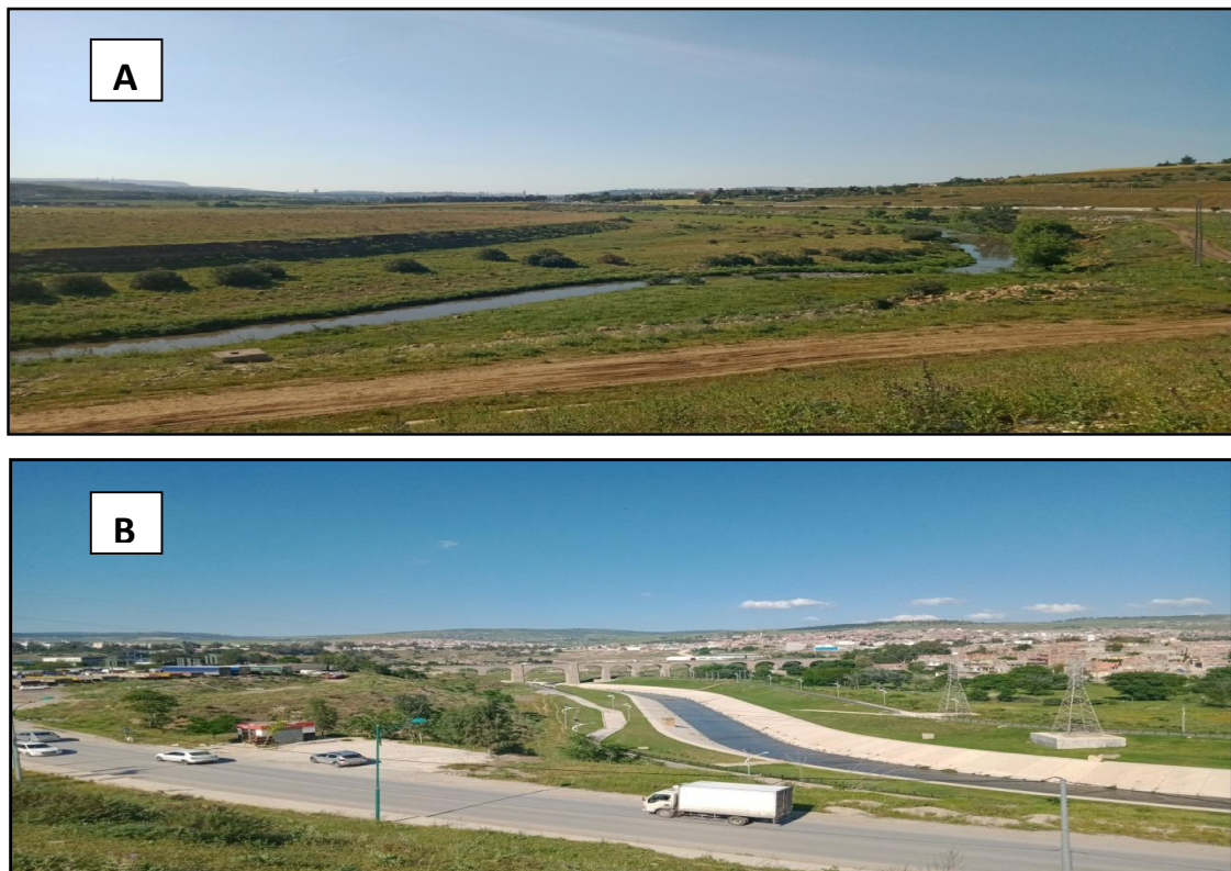
Fig. 36 Morphologie de la plaine alluviale de l'Oued Boumerzoug avec les différents lits ((A) lit mineur, lit moyen et lit majeur, (B) lit mineur après calibrage)
