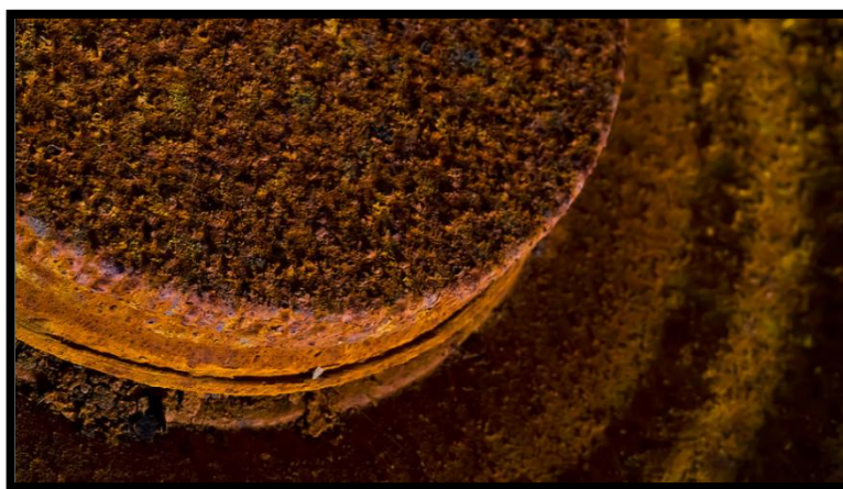
Figure I-6 : Combinaison d'une corrosion par piqûre avec la corrosion générale.
