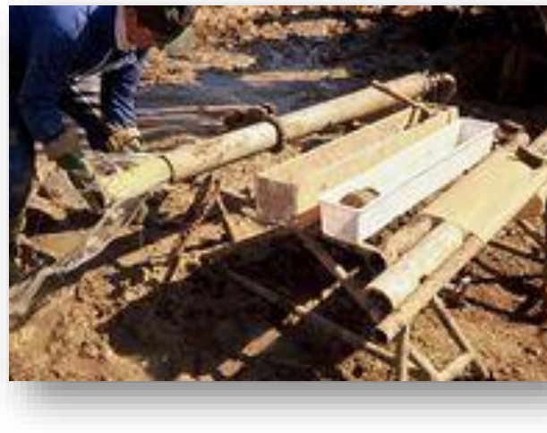
Photo 7 : Récupération des carottes
