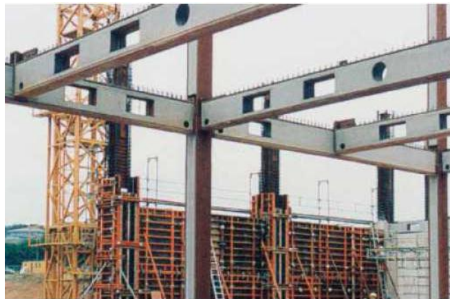
Fig. III. 4. Poutres munies d'ouvertures isolées de formes variées [2]
