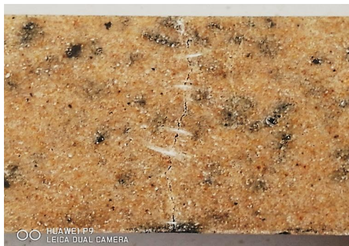
Figure XII-28a Pontage des fissures par les fibres de verre
