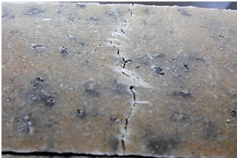
Figure XII-24 Pontage des fissures assuré par l'ajout des fibres
