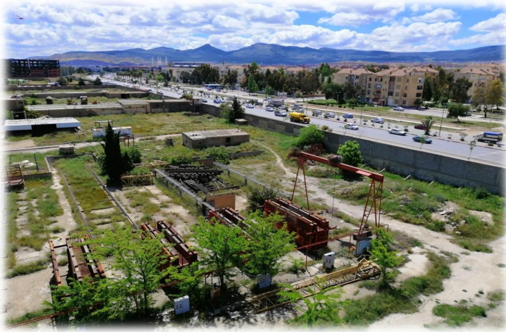
Figure 04 : la zone industrielle STRDAV(05/05/2019) (photo. personnelle)
