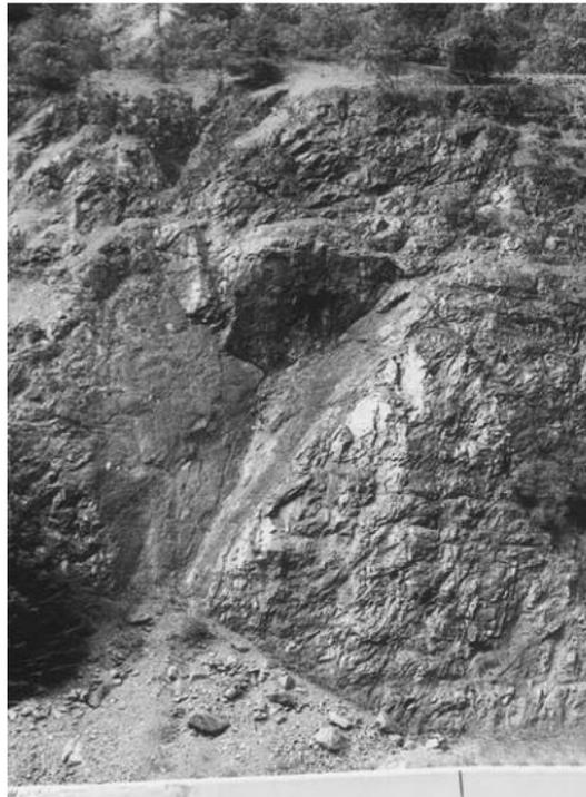
**Figure IV.5-** Rupture de coin typique impliquant un glissement sur deux joints persistants avec une ligne d'intersection coupant le talus au pied de la paroi rocheuse et un plan supérieur qui forme une surface de relachement.
