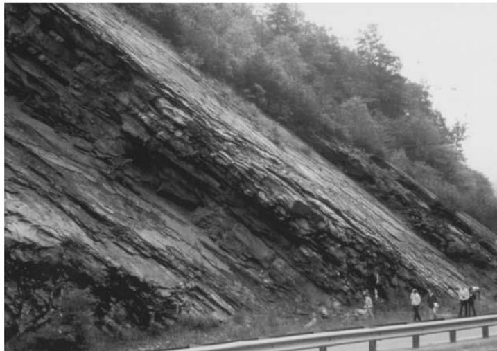
**Figure IV.3-**Photo montrant un glissement planaire
