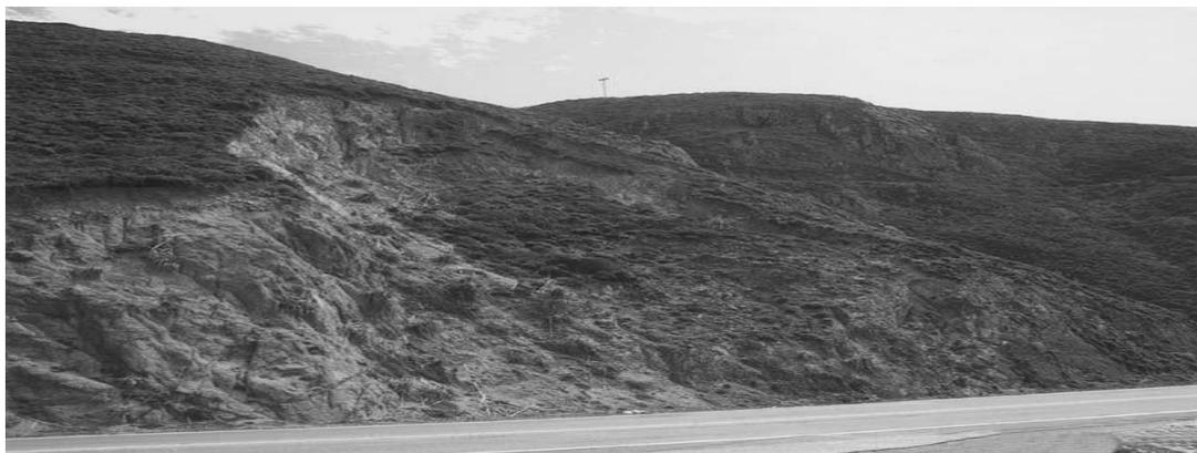
**Figure IV.8-** Rupture circulaire dans une roche granitique fortement altérée (Duncun 2008, autoroute en Californie).
