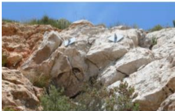
Figure 58: Exemple de confortement par boulon d'ancrage
