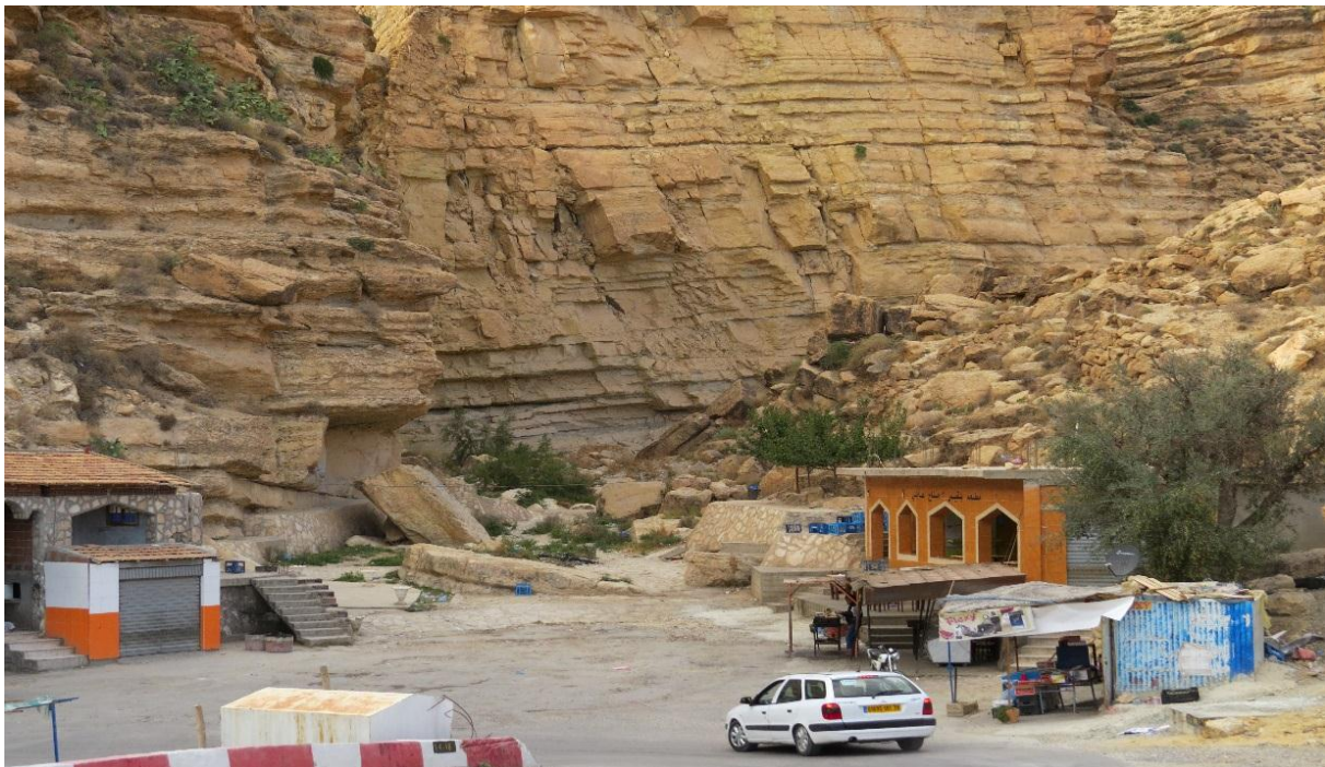
Figure 05 : Etat initial de la partie de la RN83 concernée par le projet
