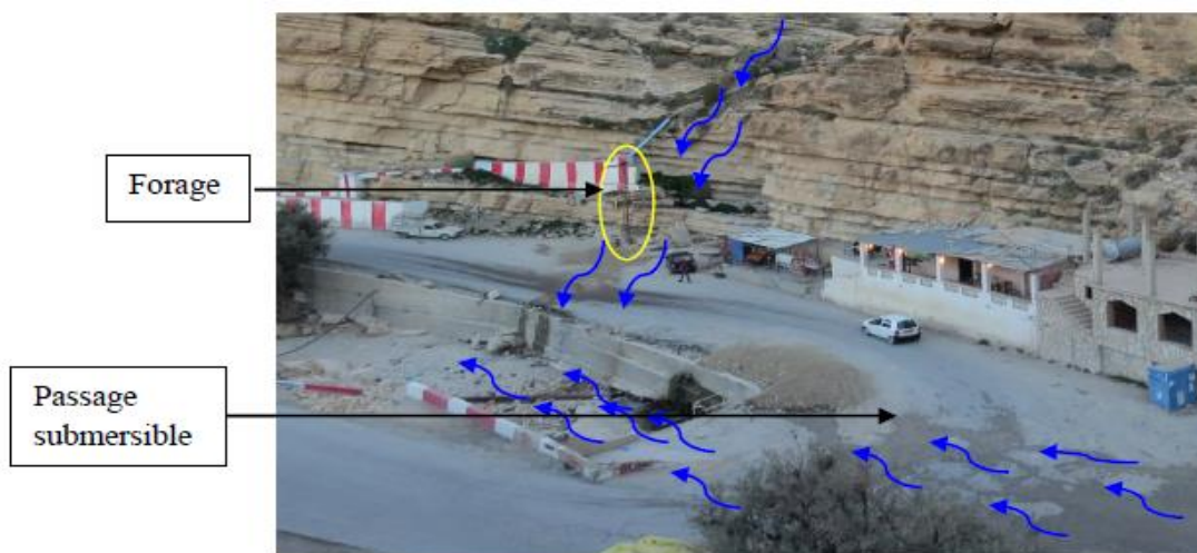
Figure 22 : une photo qui présent le forage et le passage submersible.
