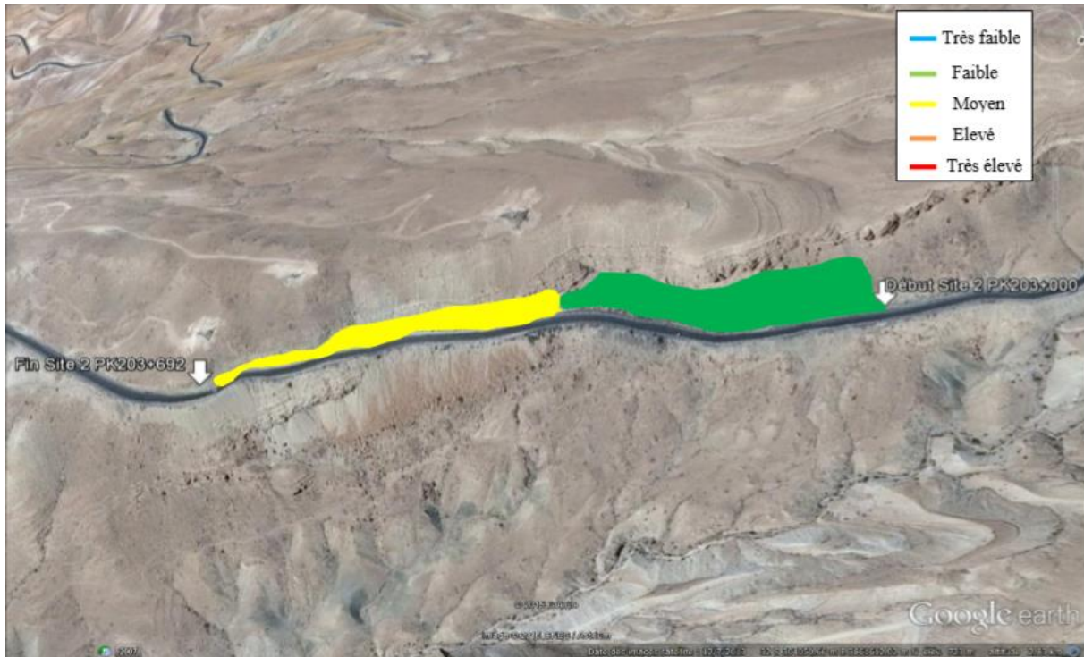
Figure 53: Site 2 (Khenchela, RN83) : Du PK203+000 au PK203+692
