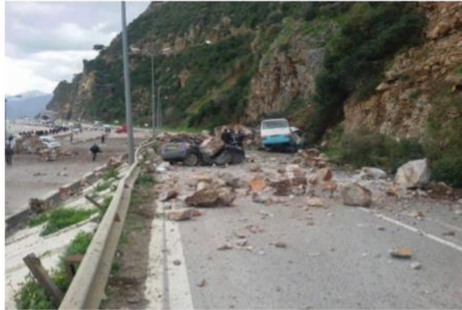
Figure 38: Eboulement rocheux sur la RN 9 à AOKAS (BEJAIA)
