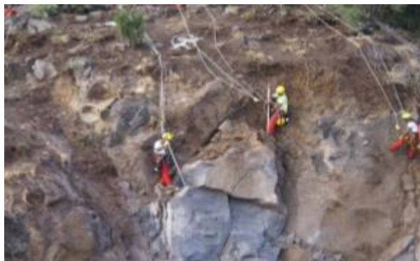
Figure61 : Exemple de déroctage et purge
