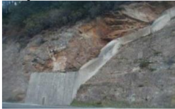
Figure 60: Exemple confortement par butée de soutènement
