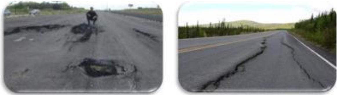
**Figure –III-3- :** Dégradations de chaussées (Ejjaaouani 2008).
