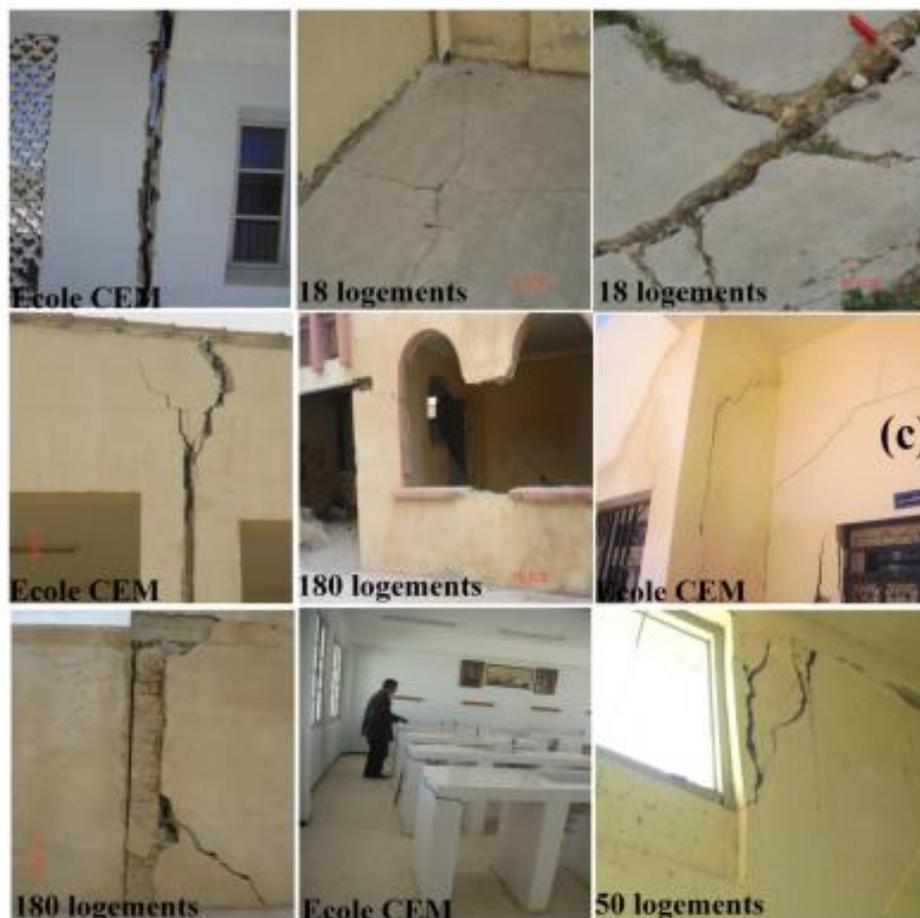
**Figure –III-2- (c) - : photos montrant l'état actuel des quelques constructions dans la région d'études ( commune d'EL Kouif) : dégradation complète de quelques constructions.**
