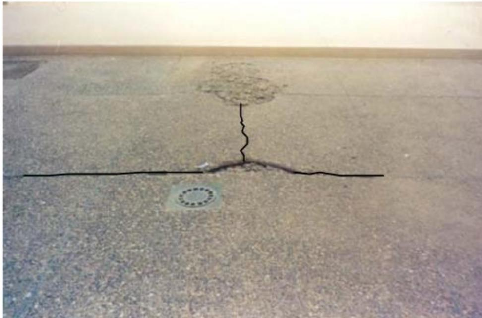
**Soulèvements local de la dalle en béton
