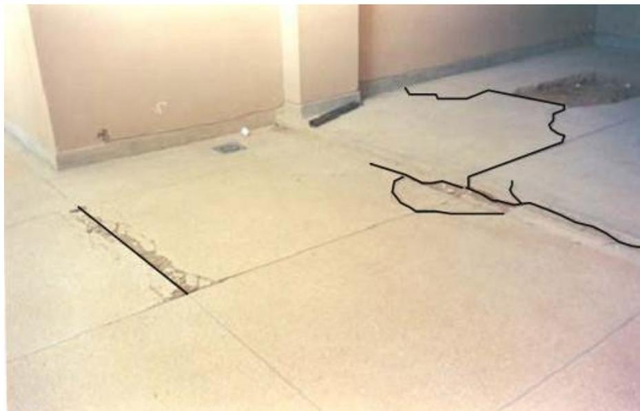
**Soulèvements et rupture de la dalle en
