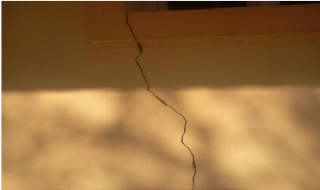
**Ouverture d'une fissure dans un mur en maçonnerie, du fait du gonflement du sol
