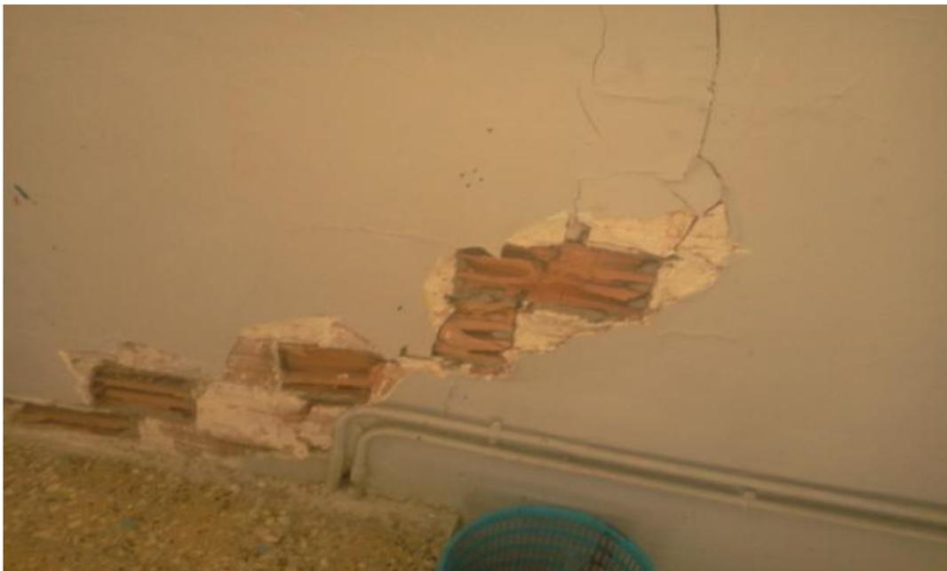
**Ouverture d'une fissure dans un mur en maçonnerie du fait du gonflement différentiel du sol.**
