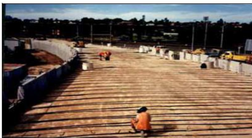
Figure 2.14. Construction d'un remblai d'accès à double parement
