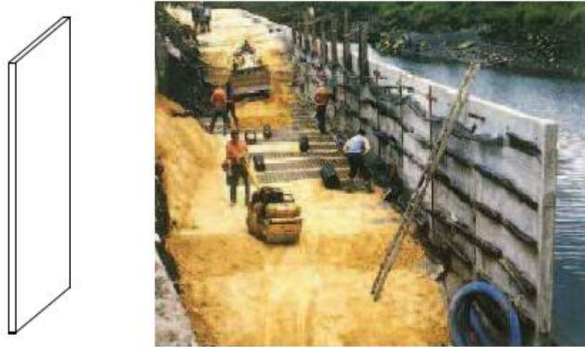
Figure 1.5. Panneaux de pleine hauteur (Farik,2013)
