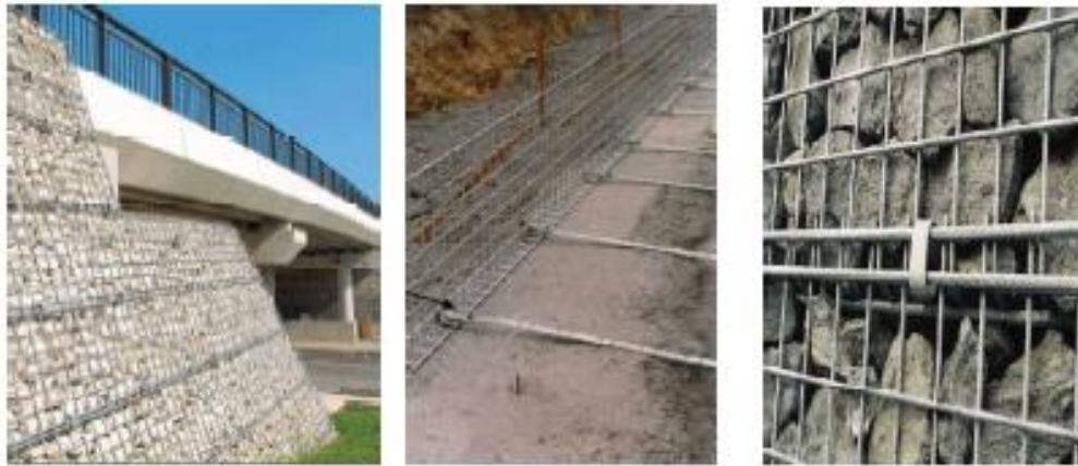
Figure 1.11. Parement treillis soudé en acier (Farik, 2013)
