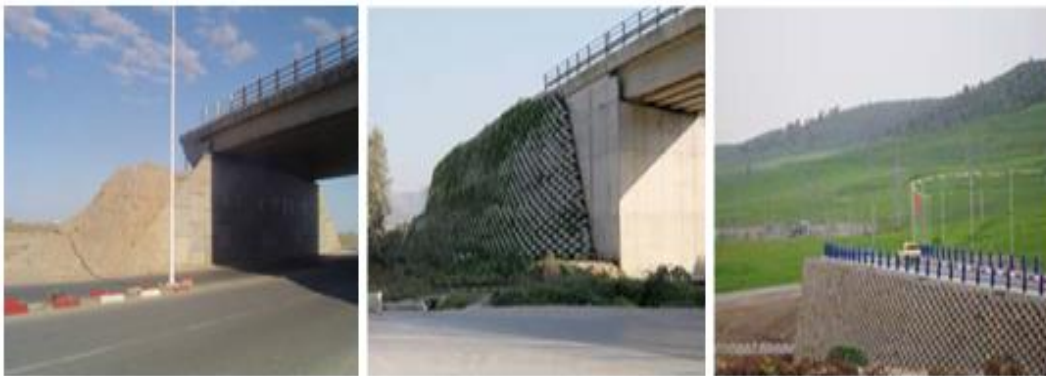
Figure 1.21. Rampes d'accès de pont réalisées en Algérie en Terre Armée (Attalaoui, 2017)
