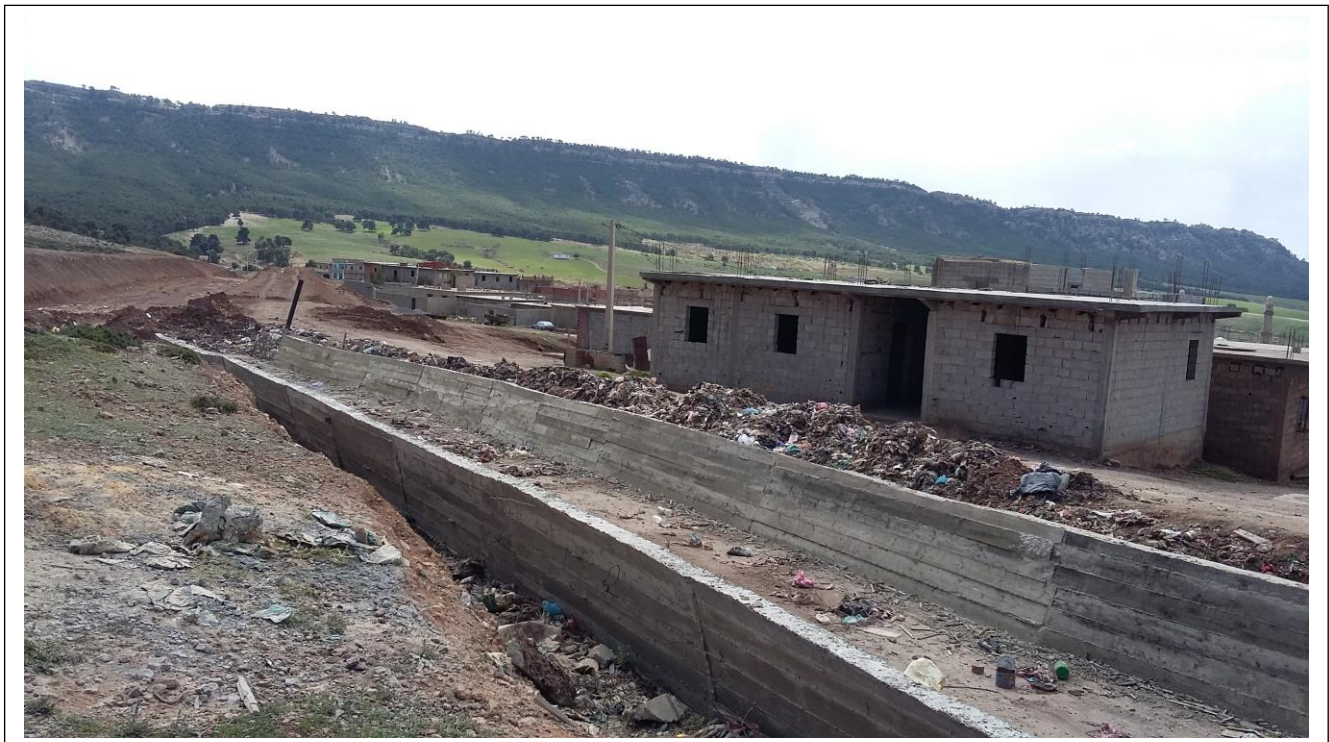
VIII. FIG. 02. A. Canal en béton arme
