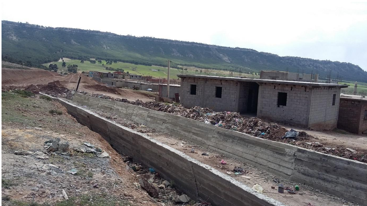
VIII. FIG. 05 .A. canal en béton arme
