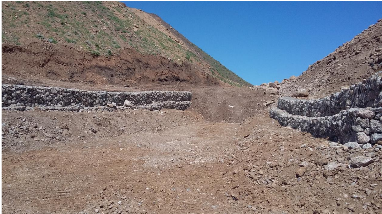
Fig. N° II.2 : Enrochement à (boukhadra - Tébessa). (algerie ,2019)
