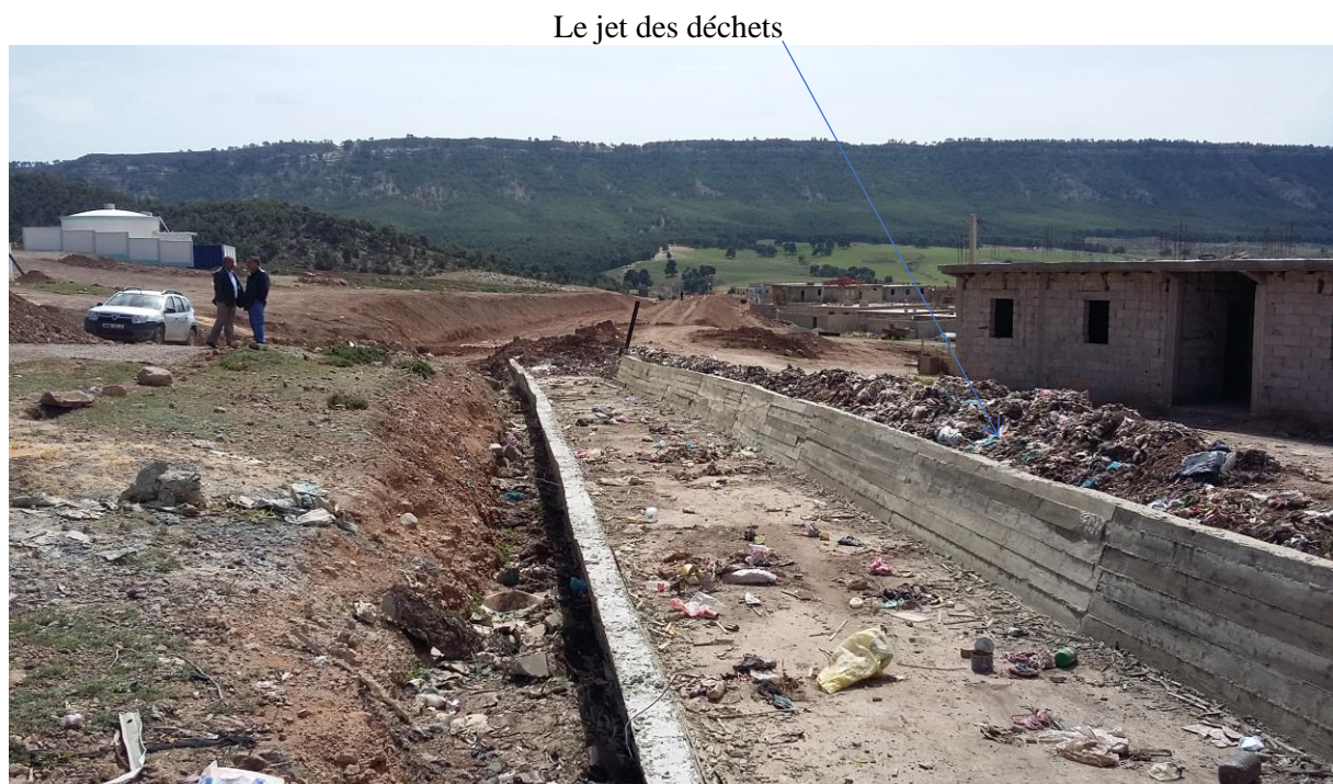
Fig. N°II.1 : Le jet des déchets dans les cours d'eau aboutit à des inondations liées aux Embâcles (oued boukhadra -Tébessa -mais 2019)
