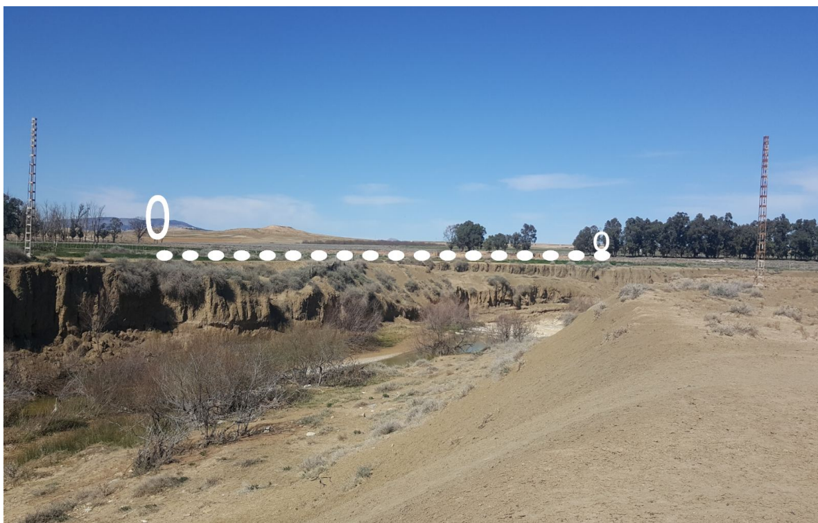
Figure 3.11 : future digue du barrage Chebabta
