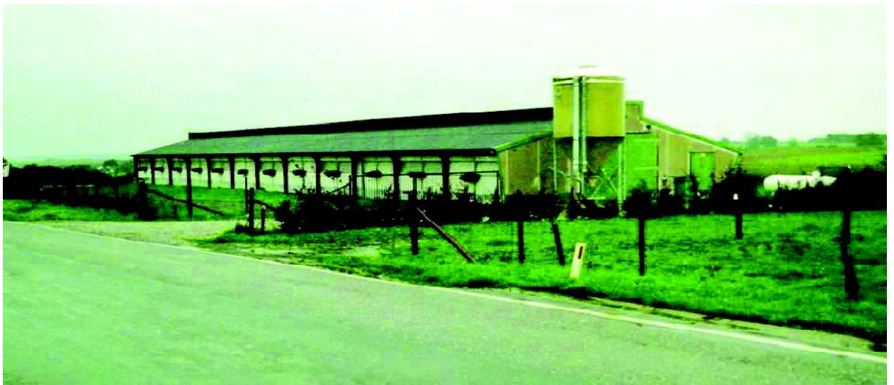
Figure(05): Poulailier à ventilation naturelle, clapets latéraux et lanterneau
