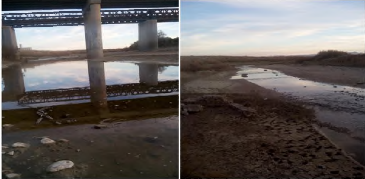
Figure 10 : Station d'échantillonnage d'Oued Mellague.
