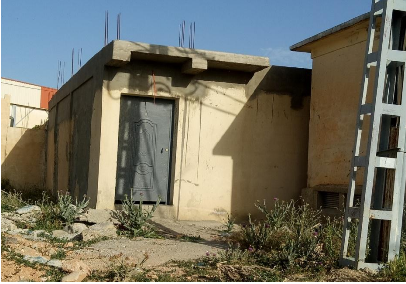
الصورة. 19: عدم احترام الاعمدة الكهربائية
