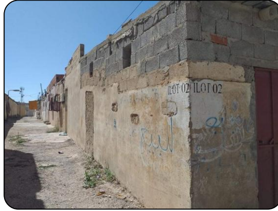
الصورة رقم(09): تمثل سكن عشوائي
