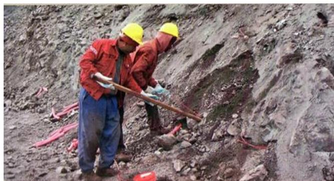
**Fig.4.7.** Chargement des trous forés avec l'explosif[52]
