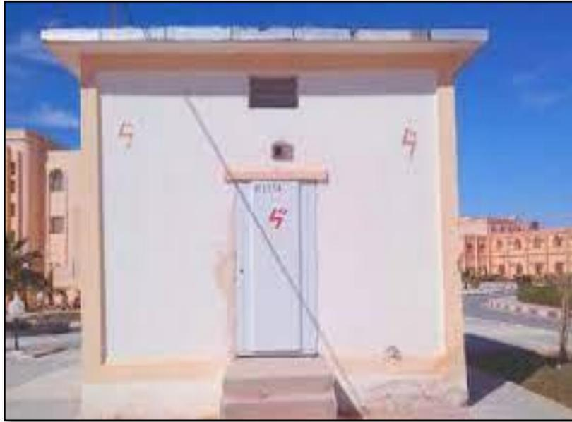
**Figure I. 8** Poste en cabine maçonnerie [9].
