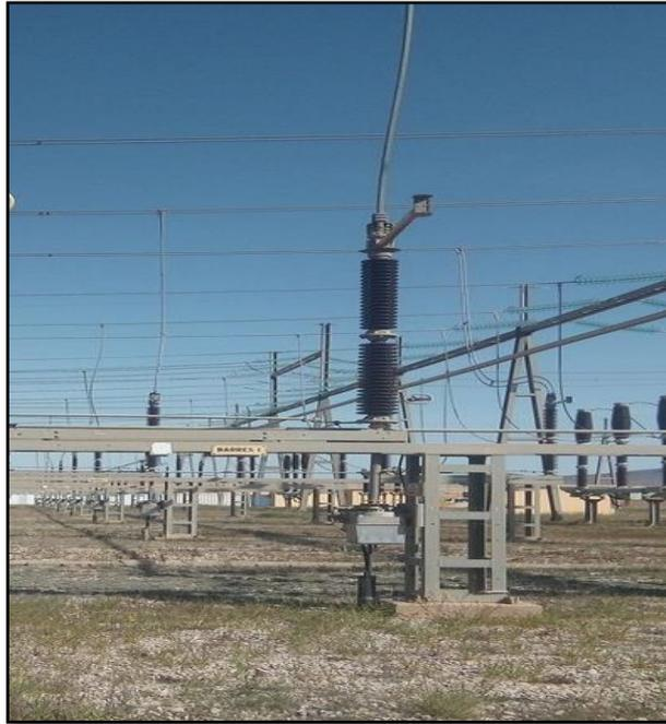
**Figure I. 27** sectionneur (poste HAMAMET 220kv).
