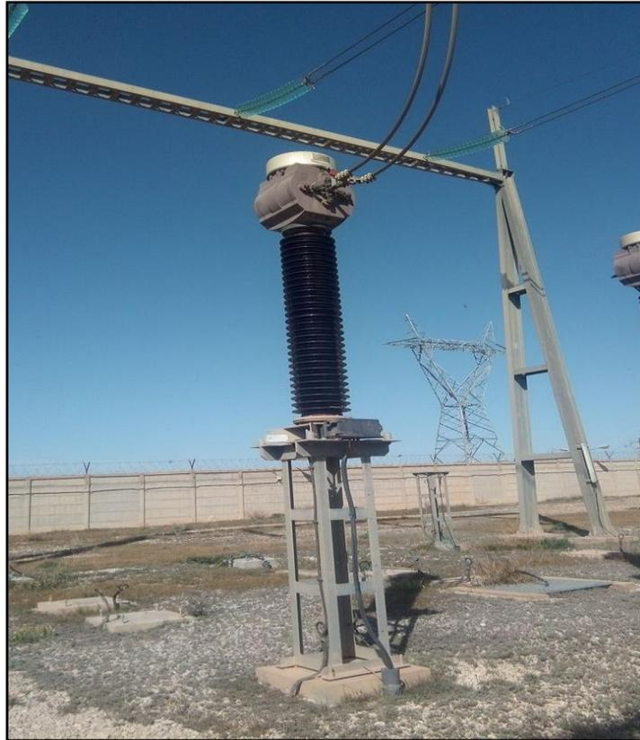
**Figure I. 26** transformateur de tension (TP) (poste HAMAMET 220kv).
