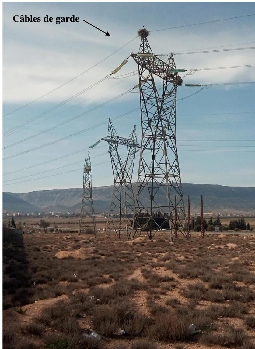
**Figure I. 14** Câble de garde (poste HAMAMET 220kv).
