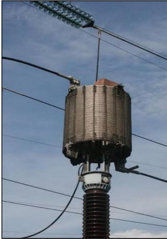
**Figure I. 29** Circuit bouchon.
