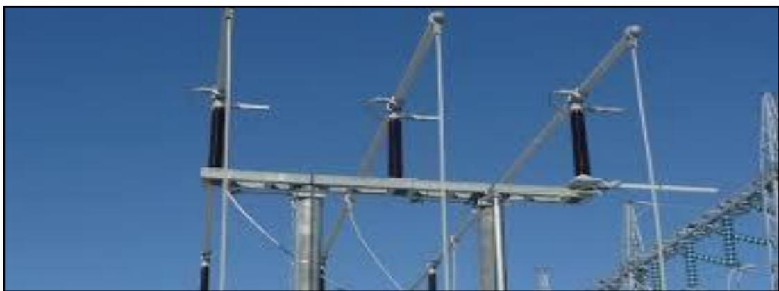
**Figure I.28** sectionneurs de mise à la terre (poste HAMAMET 220kv).
