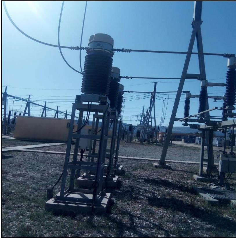
**Figure I.25** Un Transformateur de courant (poste HAMAMET 220kv).
