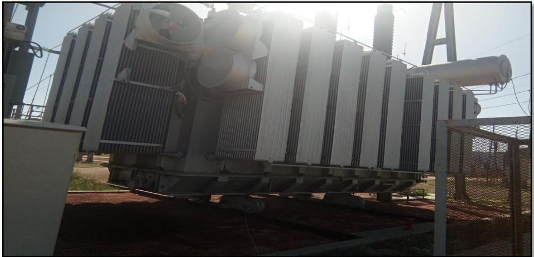
**Figure I.23** transformateur 220kv/90kv (poste HAMAMET 220kv).
