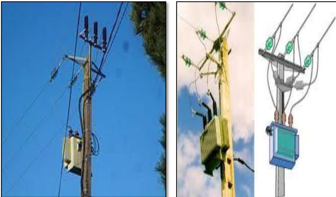
**Figure I.9** Schéma d'un poste aérien sur poteau ou pylône [10].
