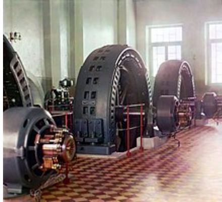
FIG01 : Alternateur du début du XXe siècle fabriqué à Budapest, Hongrie, dans le hall de production d'énergie d'une centrale hydroélectrique (photographie de Sergueï Prokoudine-Gorski, 1905-1915).
