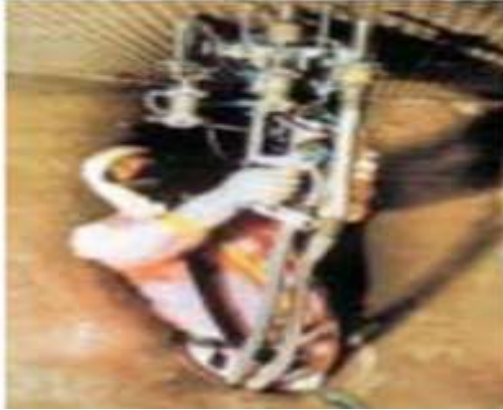
Figure 113 : Travailleur du nucléaire contrôlant des tubes de générateurs de vapeur. [24]
