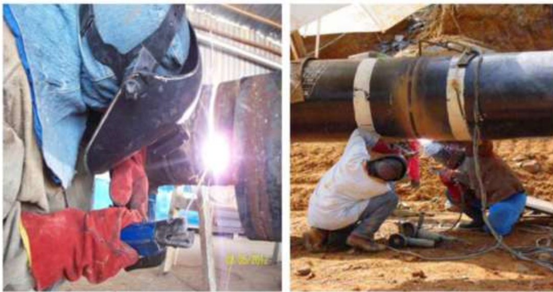
Figure 59 : Soudage des pipelines (Type manuel). [11]
