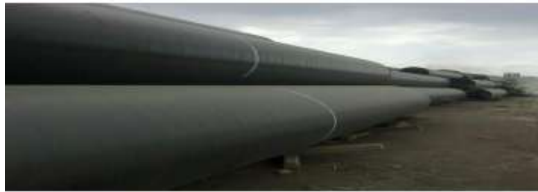
Figure 55 : Tubes transporteurs du GPL. [13]
