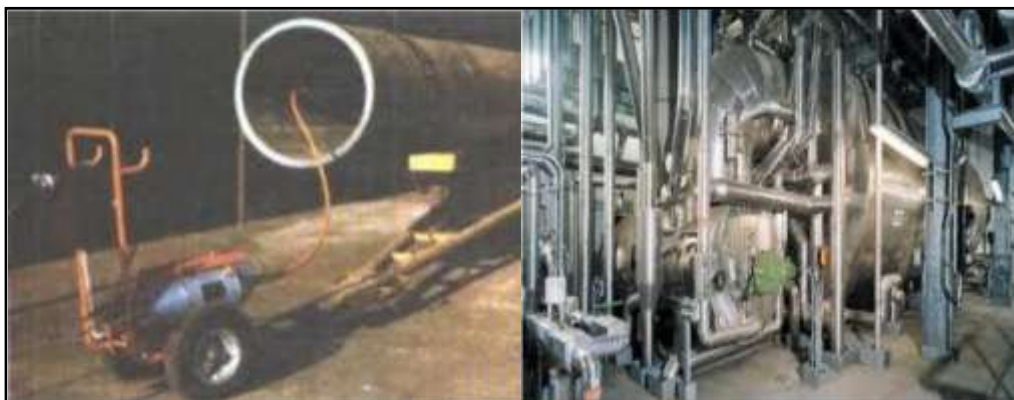
Figure 73 : La mise en œuvre du contrôle par radioactivité. [16]
