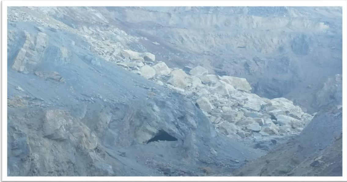
Figure .III.II.9: Effondrement du carrier BK2
