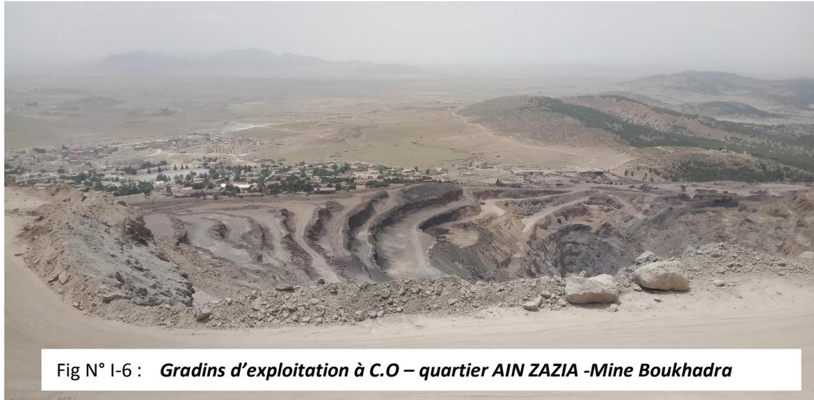
Fig N° I-6 : **Gradins d'exploitation à C.O – quartier AIN ZAZIA -Mine Boukhadra**
