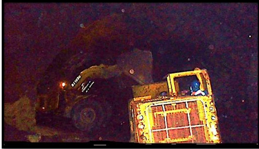
Figure 14 : Procédure de chargement dans la mine souterraine de Boukhadra. [7]
