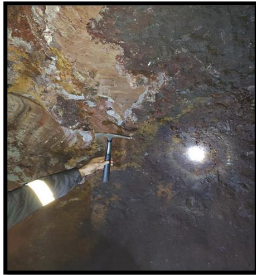
Figure 3 : zone d'échantillonnage contact (Minerai / Marne) au dernier point de la galerie.
