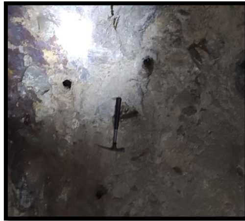
Figure 10 : Trous forés dans les travaux d'ouverture de la phase 4 ème [7]
