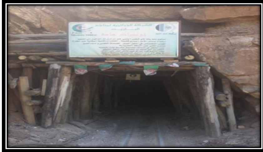
Figure.III.03 : Galerie de roulage
