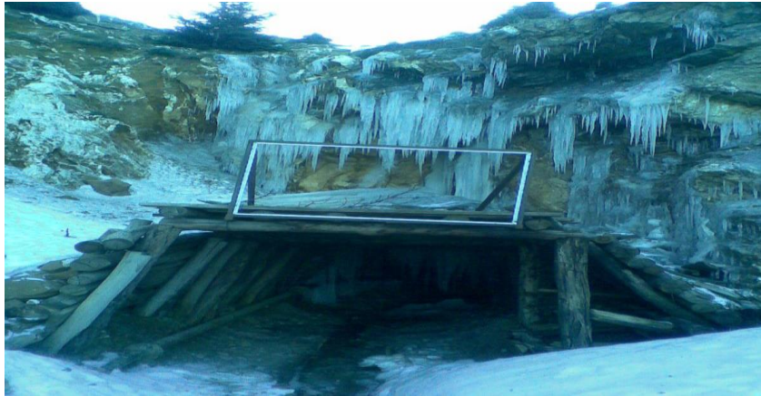
Figure II .05 : L'entrée de la galerie du niveau 1770 m
