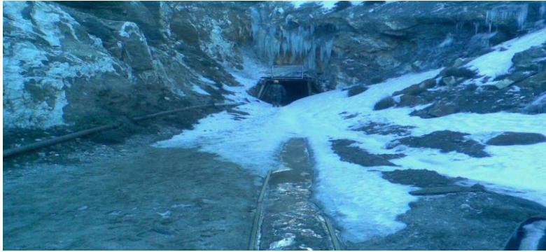
Figure II .07: L'entrée de la galerie du niveau 1690 m
