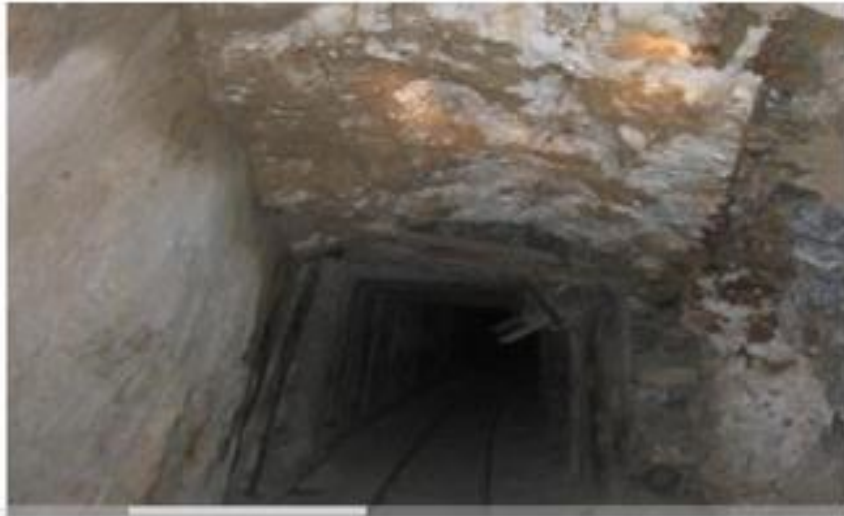
Figure I.11: Galerie d'exploitation souterraine de barytine (Algérie) [6].
