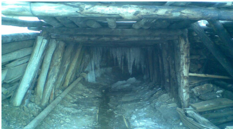
Figure II .06 : L'entrée de la galerie du niveau 1730 m
