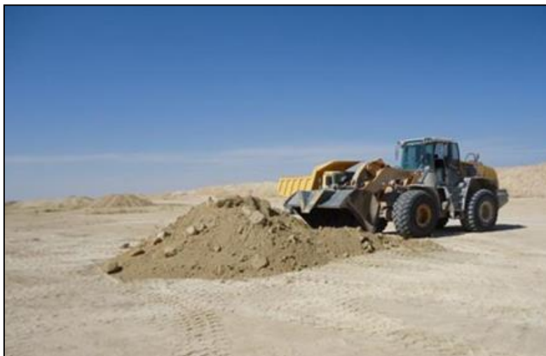
Fig. 15. L'homogénéisation du minerai de phosphate de Bled El-Hadba (FERPHOS).
