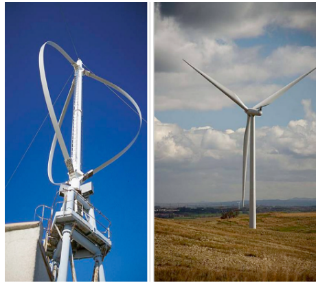
Figure 1.9 – Eolienne à axe vertical (a) et axe horizontal (b) [8].
