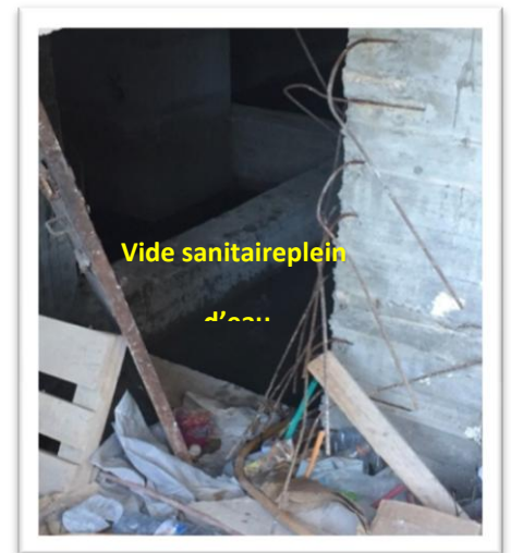
Figure IV.25: Aperçu un vide sanitaire bloc B7 [43]
