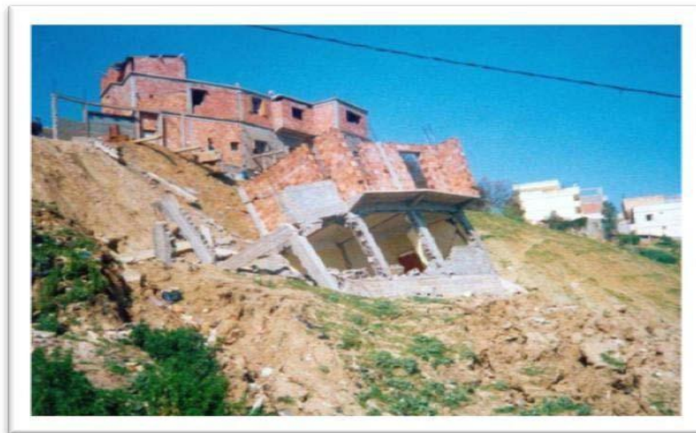
Figure1.23 : Glissement de Tizi quartier de Bejaia. Basculement d'une habitation[52]
