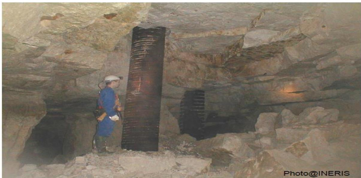
**Figure II.21.** Pieu traversant une cavité. (INERIS, 2016).
