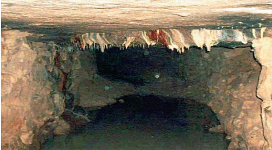
**Figure.I.08.** Venues d'eau en carrière par infiltration suite à des fuites de réseaux persistante (Bagneux-haut-de seine). (IFSTTAR, 2014).
