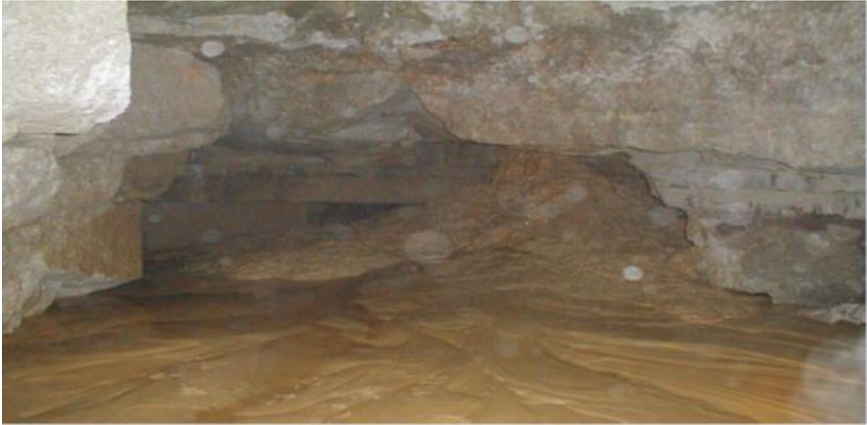
**Figure II.16.** Comblement par coulis de silicate. (INERIS, 2016).
