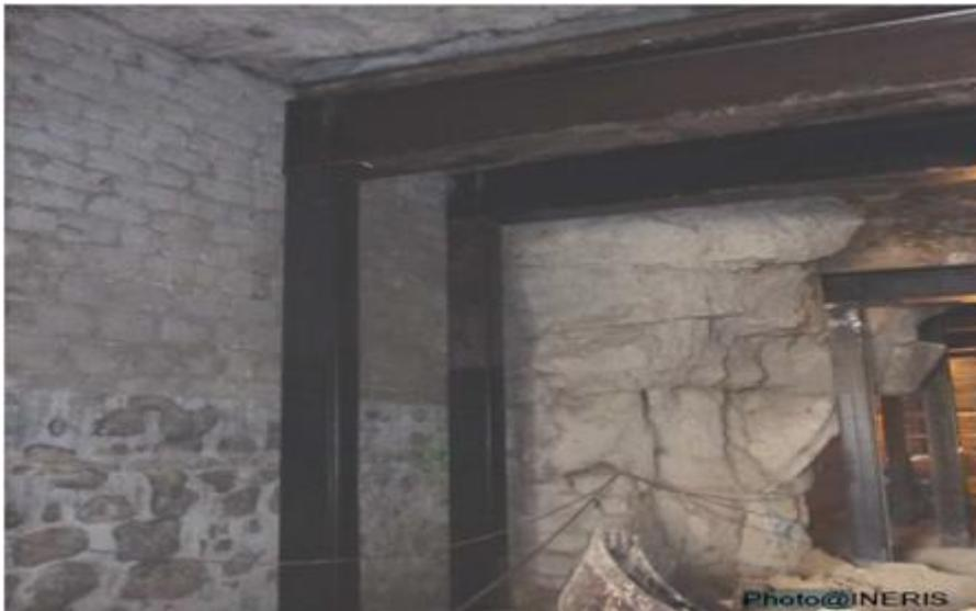
**Figure II.14.** Soutènement par portique.
