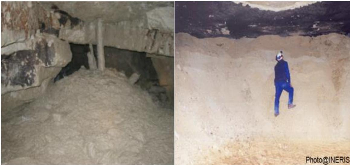
**Figures II.15.** Comblement par déversement gravitaire (INERIS, 2016).
