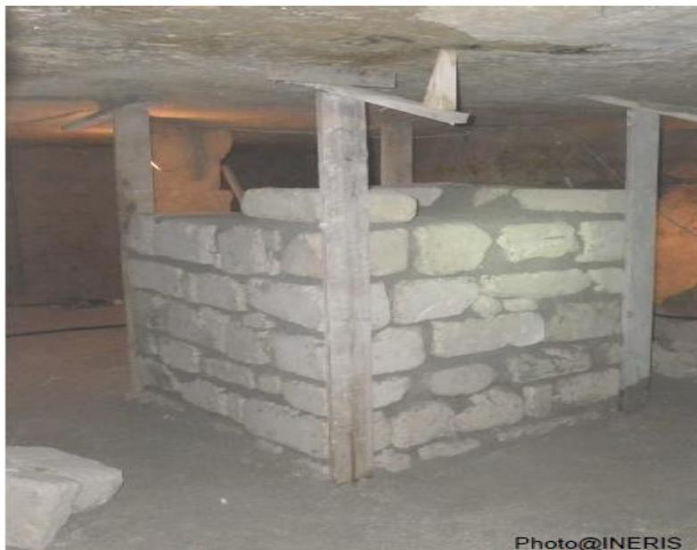
**Figure II.13.** Construction d'un pilier maçonné.
