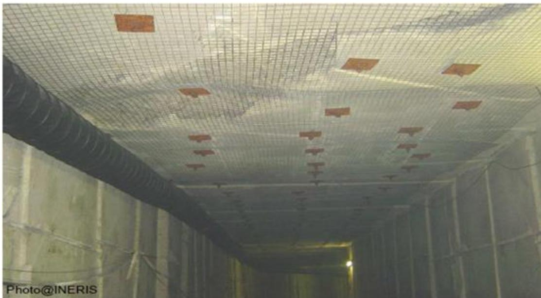
**Figure II.11.** Boulonnage du toit d'une galerie. (Source, INERIS).
