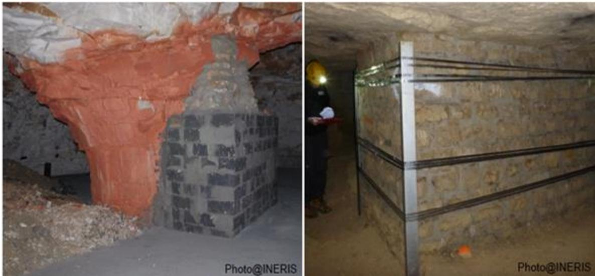
**Figure II.12a et b.** Reprise d'un pilier par maçonnerie Cerclage-ceinturage d'un pilier.
