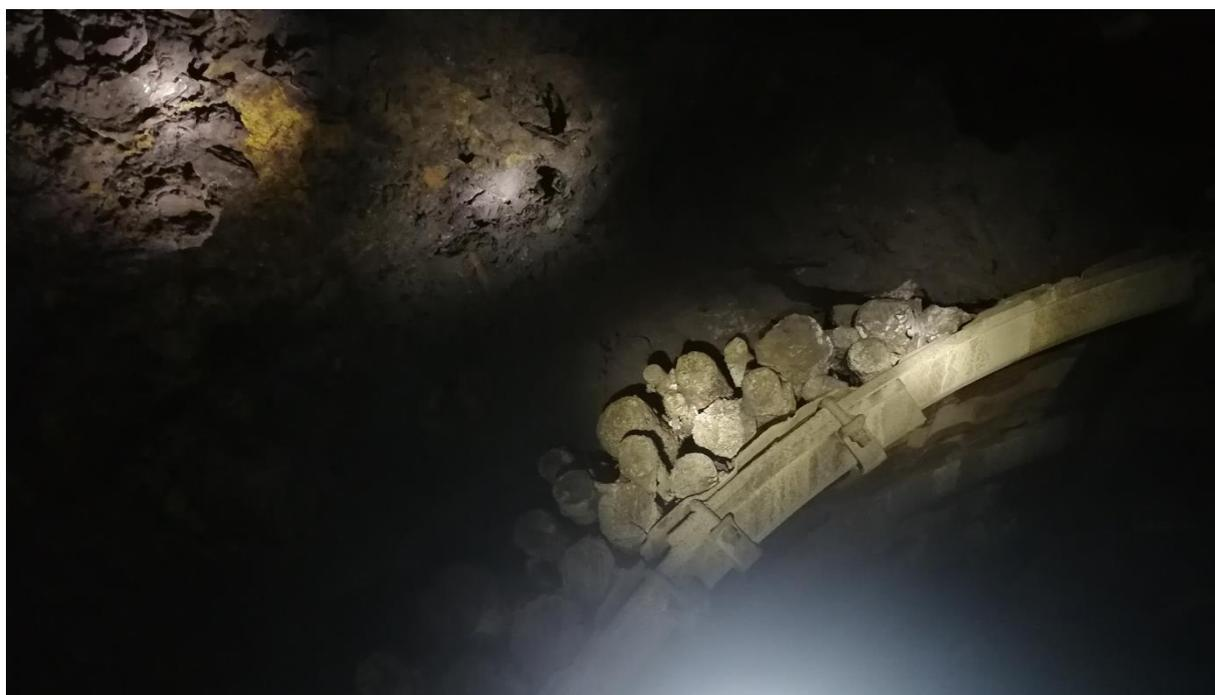
**Photo 2.** Cintre métallique (soutènement de galerie dans la mine).
