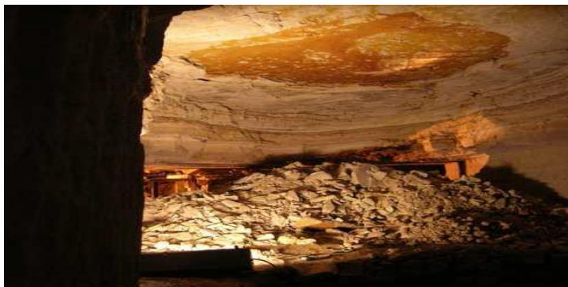
Figure.I.23. Remontée de voûte observée en souterrain (cliché INERIS).
