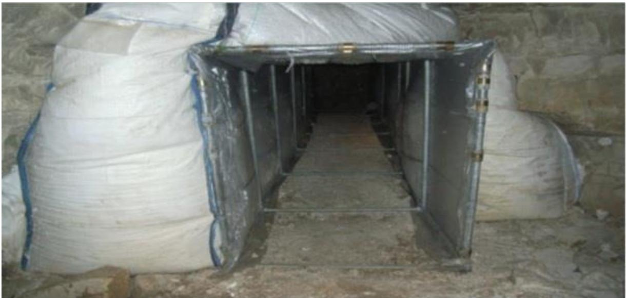
**Figure II.17.** Tunnel édifié à travers la mousse expansive pour maintenir un passage. (INERIS ,2016).
